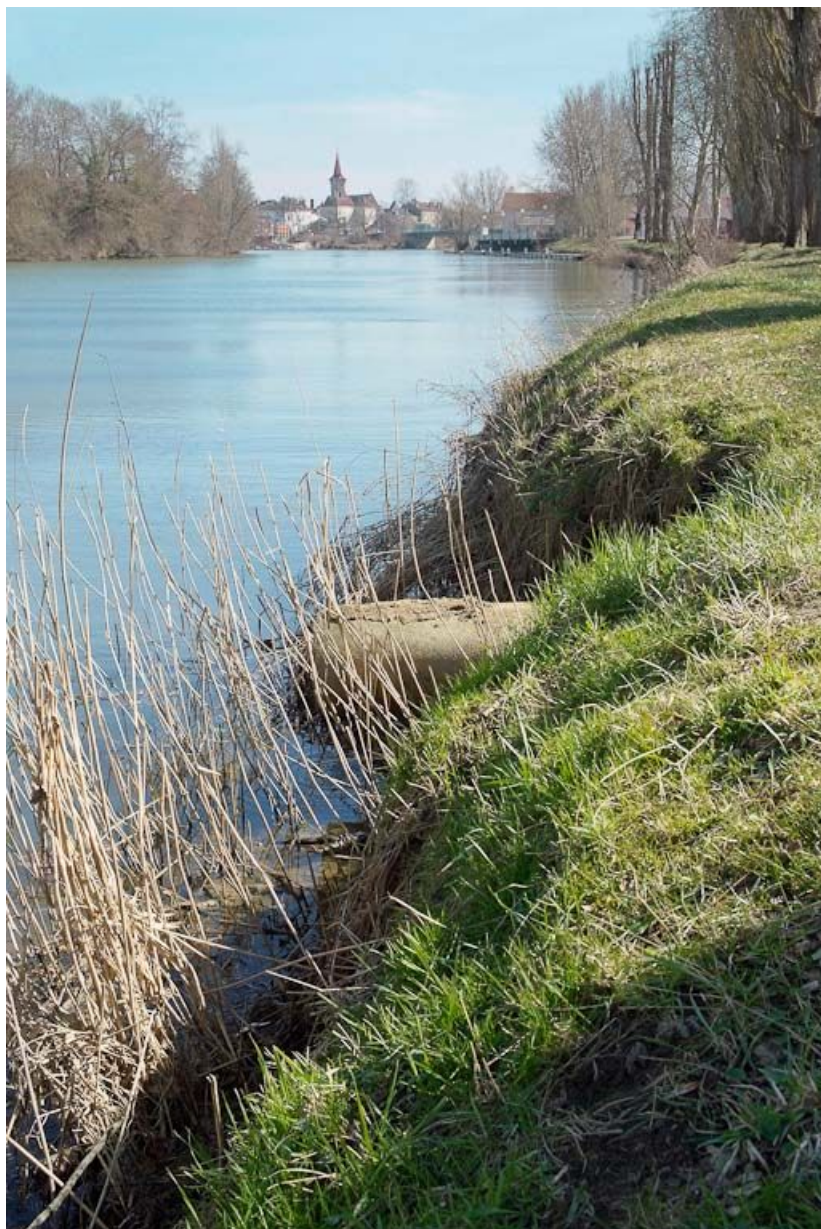
Aqueduc de Maubey, rive gauche de la Seille, vue d'aval, avec Louhans en arrière-plan. 71, Louhans
