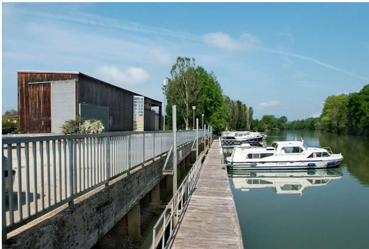
Port de Louhans. A gauche, la capitainerie, vue d'aval.
