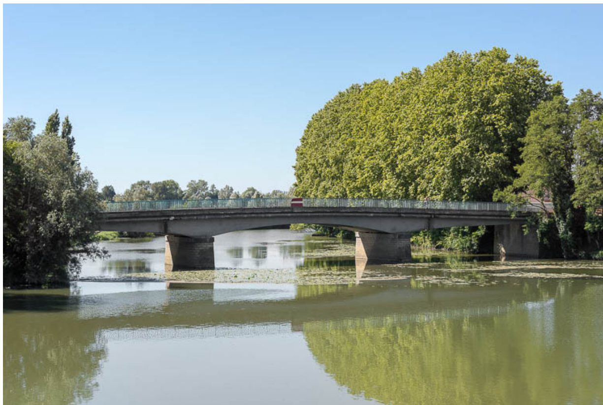
Vue d'ensemble du pont.
