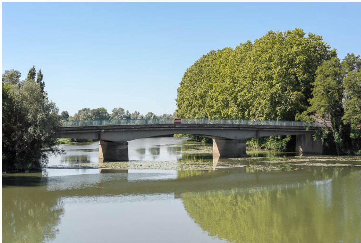
Vue d'ensemble du pont.
