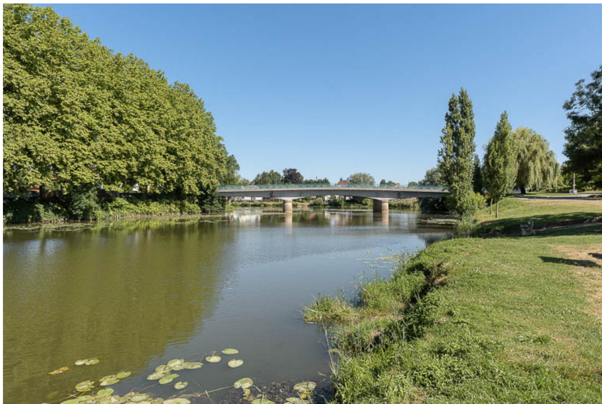
Vue générale du pont et du site.
