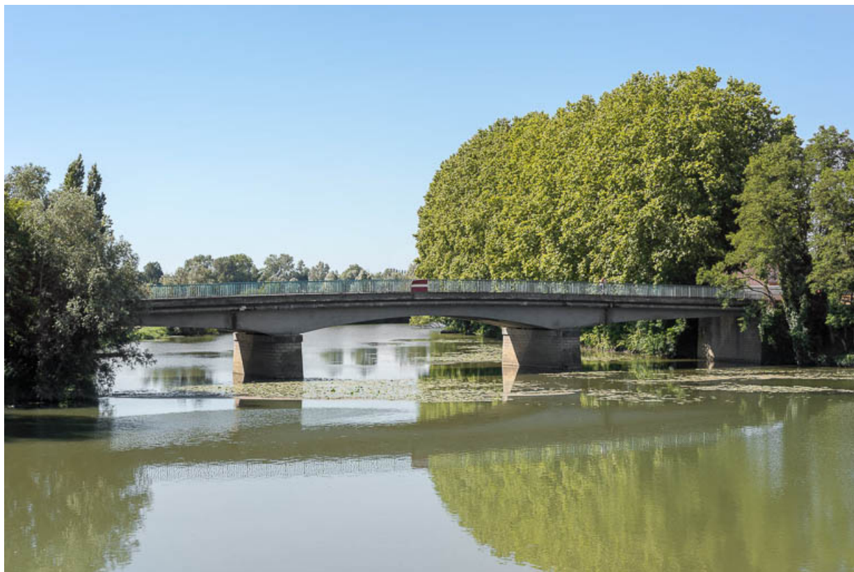
Vue d'ensemble du pont.
