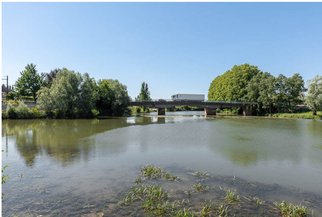
Vue générale du pont et du site.
