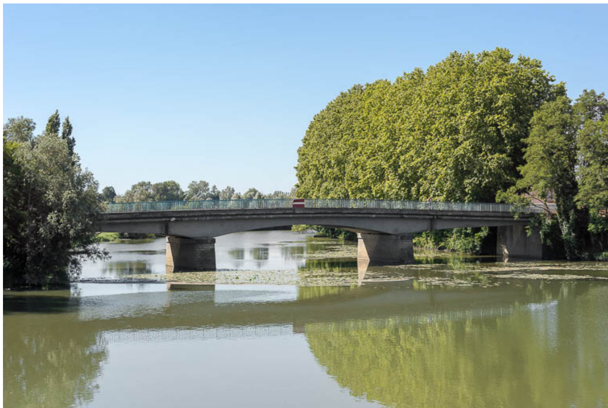
Vue d'ensemble du pont.
