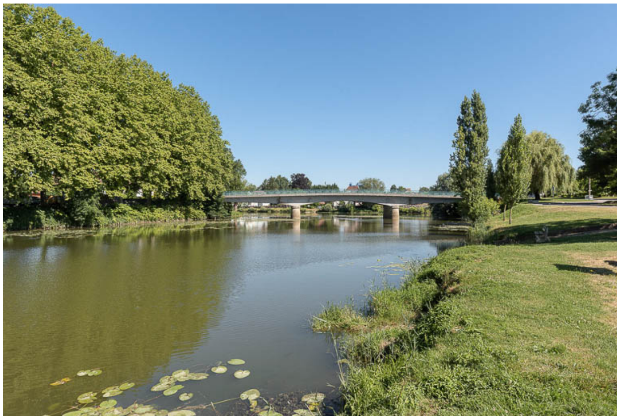
Vue générale du pont et du site.
