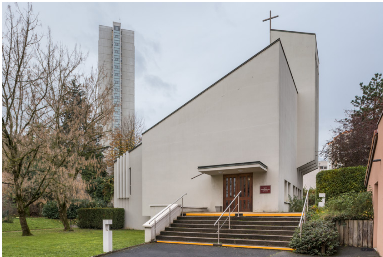
Vue de la façade est.
