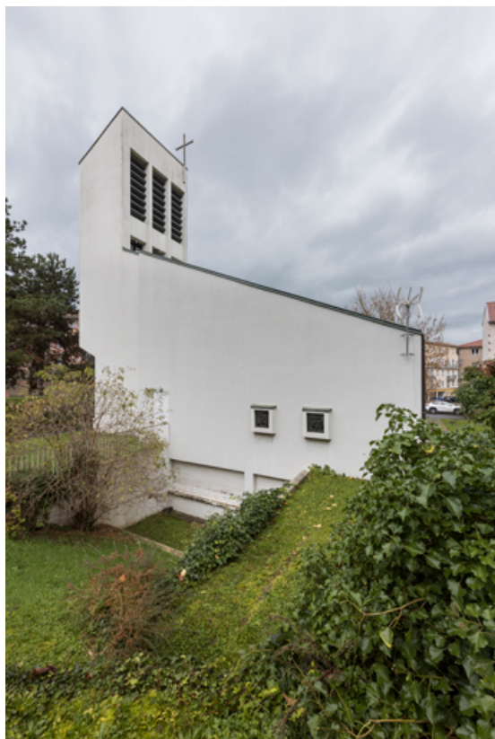
Vue de la façade ouest (de trois-quarts).
