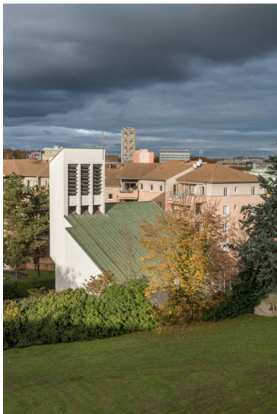
Vue du temple, sa couverture en cuivre et son clocher. 71, Mâcon, 32 rue Saint-Antoine
