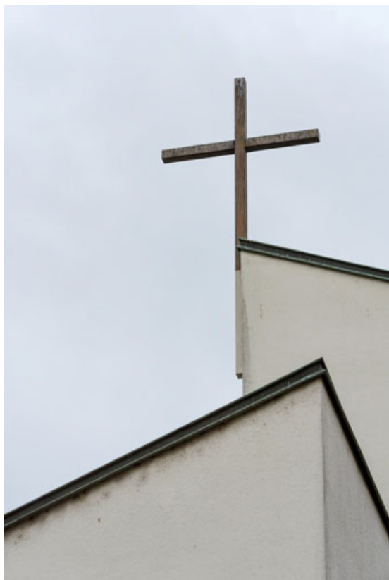
Détail de la croix sur le clocher.
