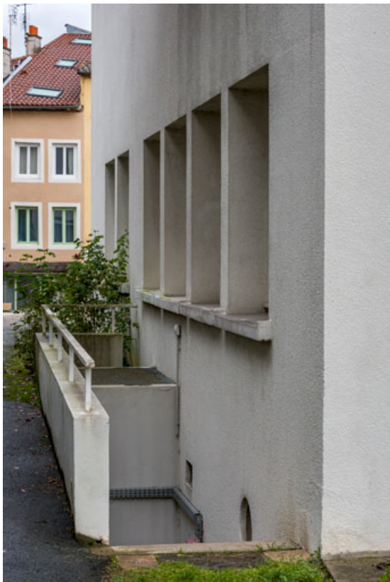
Vue partielle de la façade nord et de l'escalier desservant la chaufferie en sous-sol. 71, Mâcon, 32 rue Saint-Antoine
