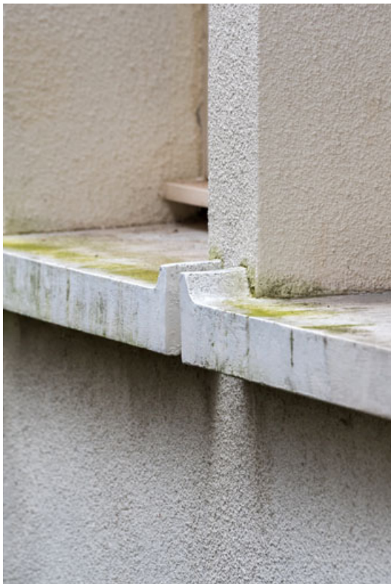
Détail des appuis saillants des baies de la façade nord.
