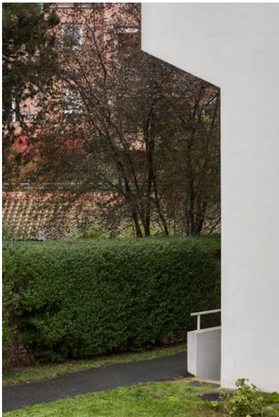
Détail de l'angle nord-ouest du temple.
