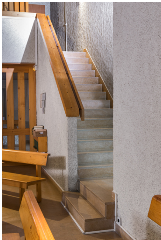
Vue de l'escalier de la tribune.
