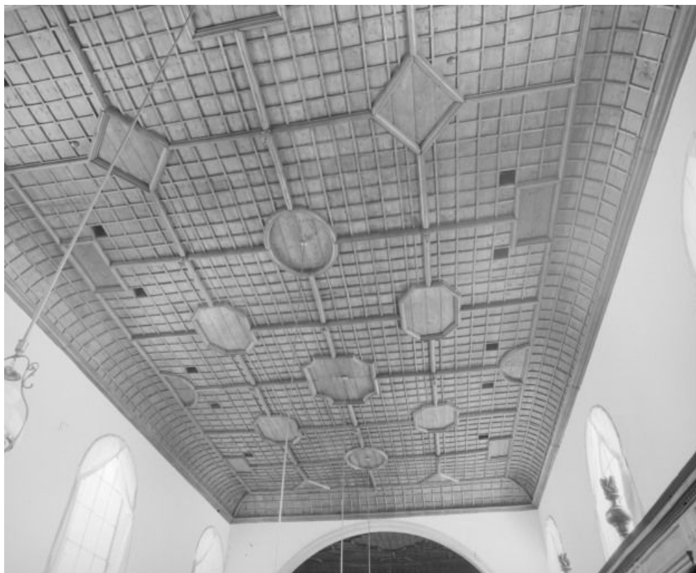
Salle des femmes, vue d'ensemble du plafond.
