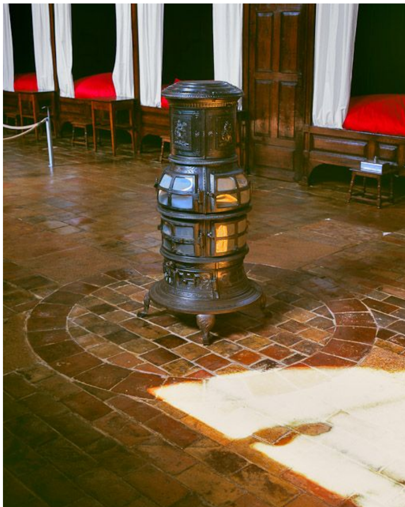
Salle des hommes, poêle de chauffage.
