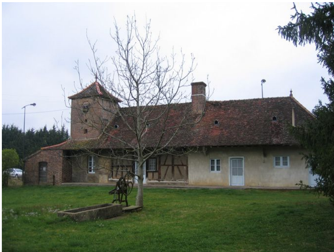
Vue d'ensemble de la façade de la maison.
