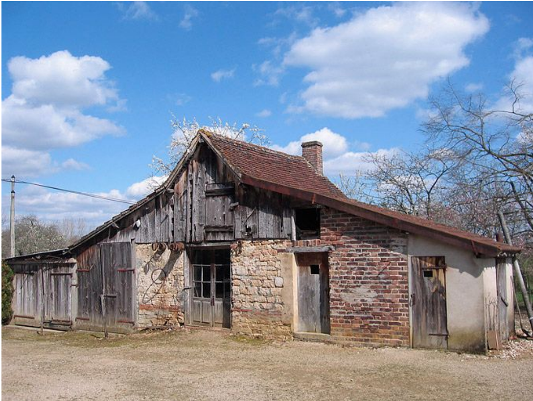
Vue d'ensemble de la façade de l'atelier-four.
