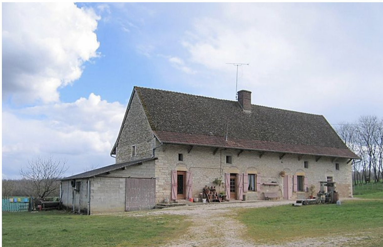
Vue d'ensemble de la façade de la maison.
