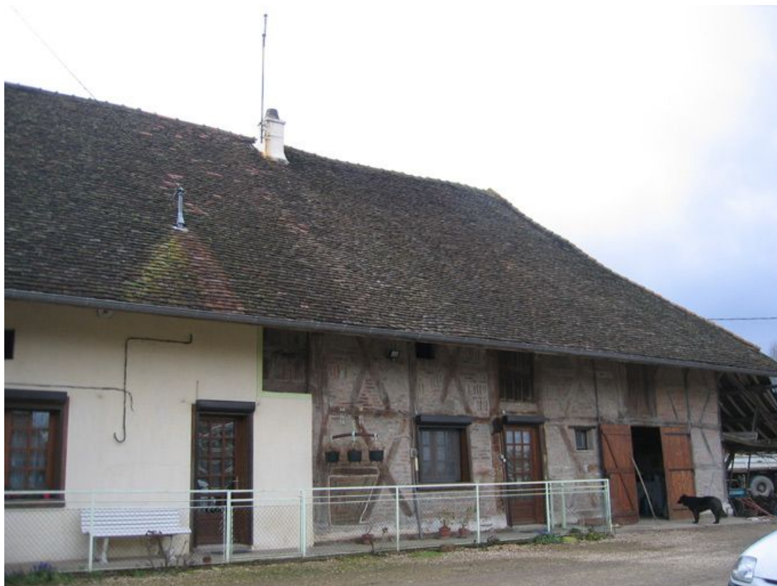
Vue d'ensemble de la façade du logis.
