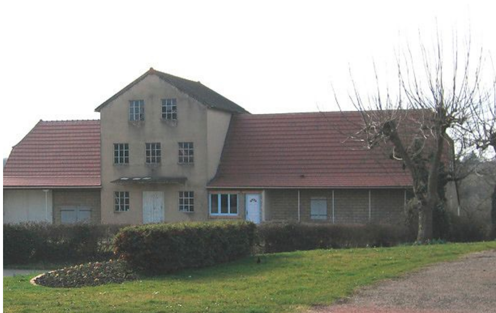
Vue d'ensemble de la façade du moulin.
