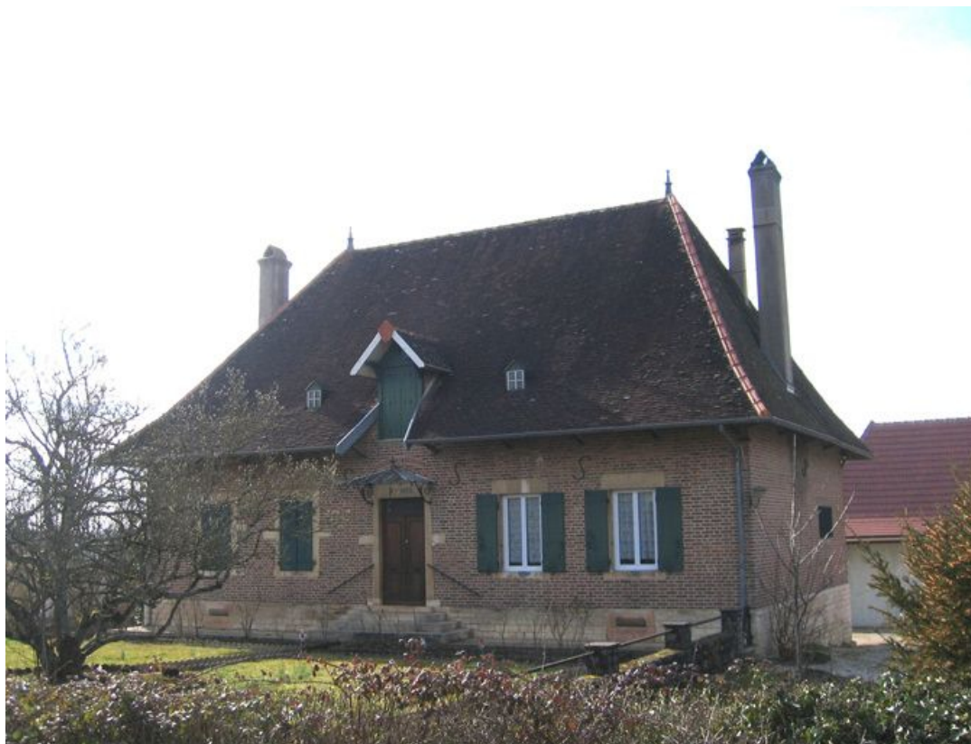
Vue d'ensemble de la façade de la maison.
