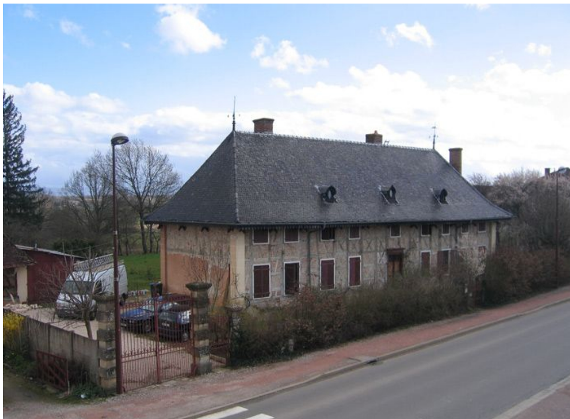
Vue d'ensemble de la façade.
