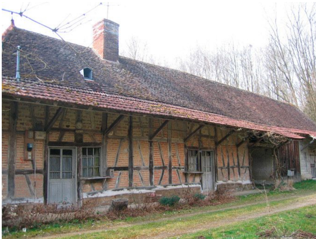
Vue d'ensemble de la façade de la ferme.
