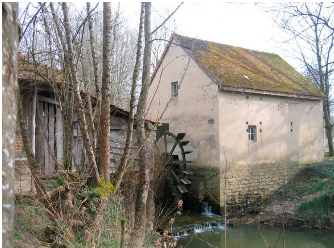
Vue d'ensemble de la façade postérieure du moulin.
