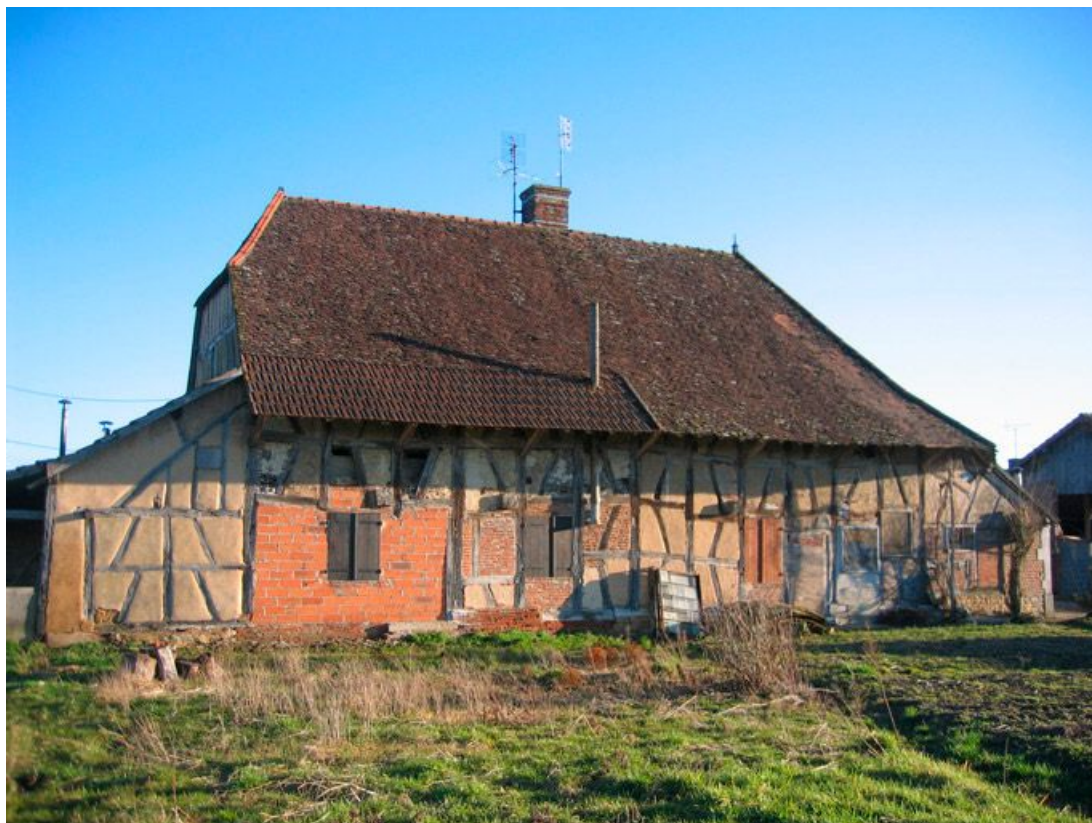
Vue d'ensemble de la façade postérieure.
