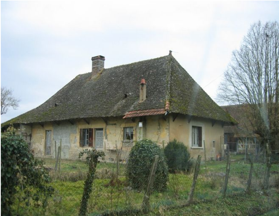
Vue d'ensemble de la façade postérieure de la maison.
