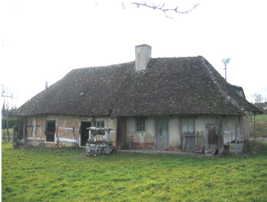
Vue d'ensemble de la façade.
