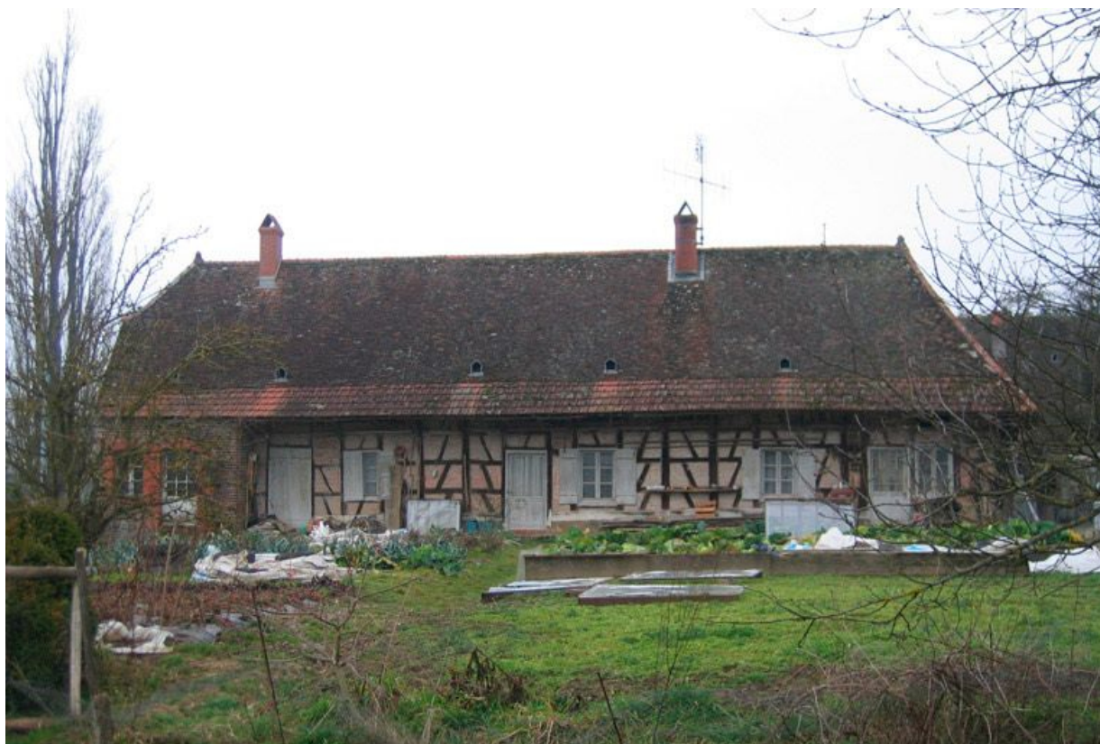
Vue d'ensemble de la façade postérieure de la maison.
