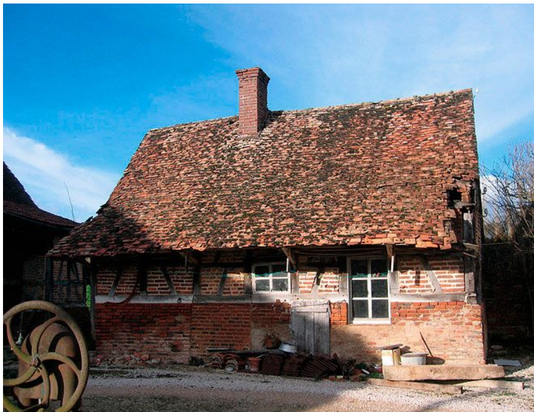
Vue du petit pan gauche du four à pain.
