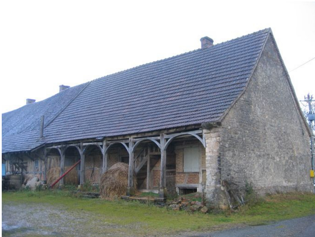
Vue d'ensemble de la façade antérieure.
