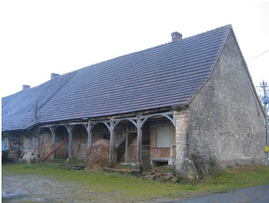
Vue d'ensemble de la façade antérieure.
