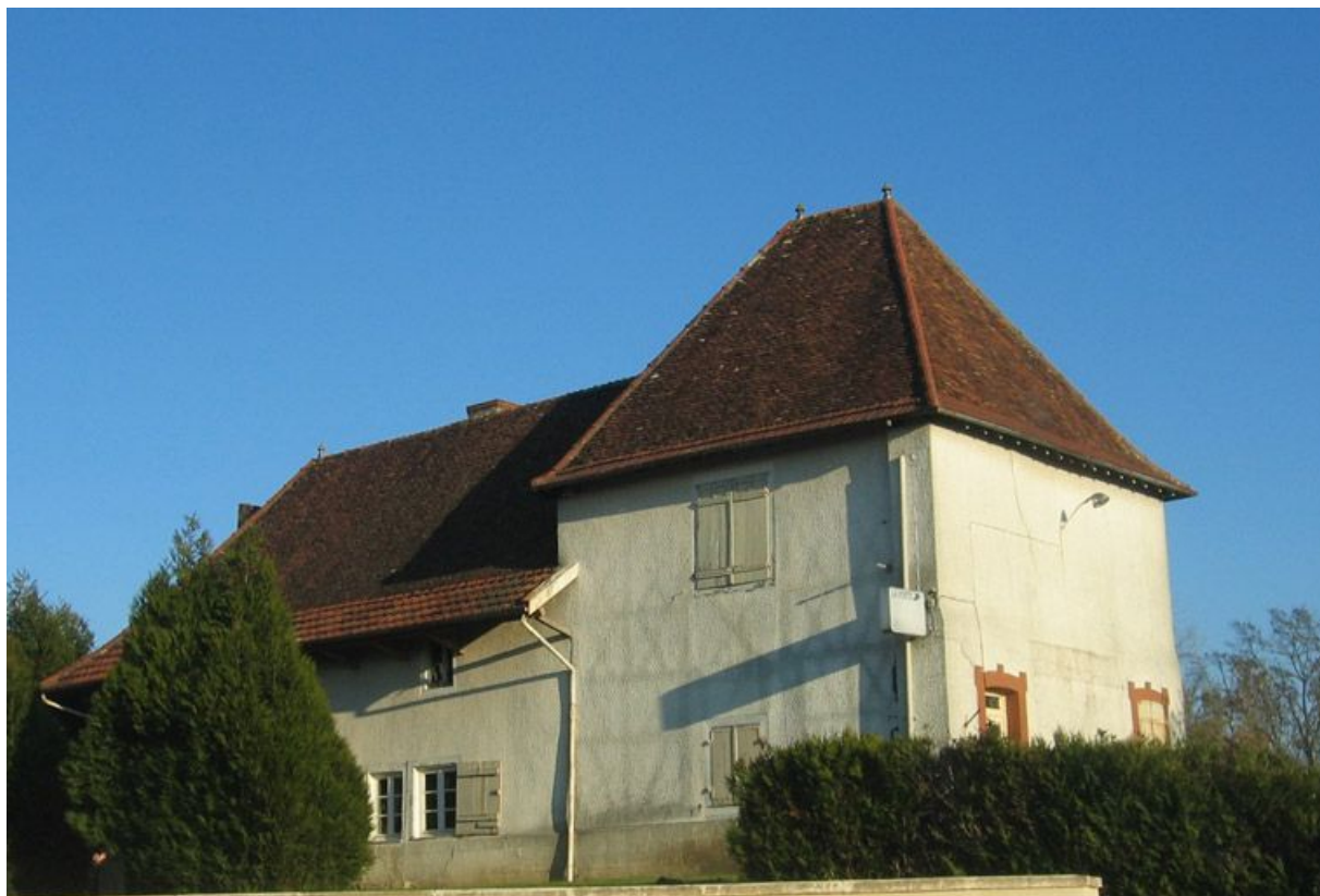
Vue d'ensemble de la façade.
