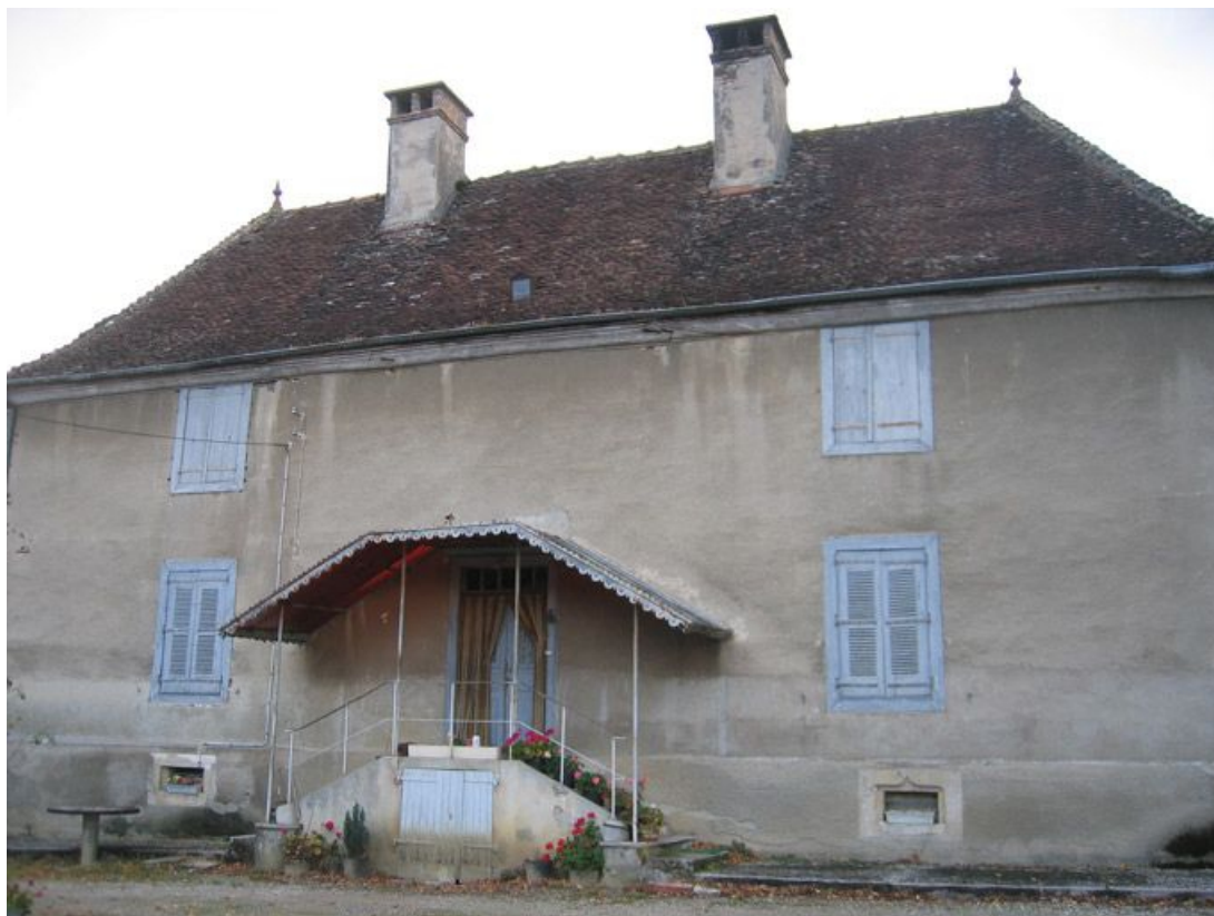
Vue d'ensemble de la façade de l'habitation.
