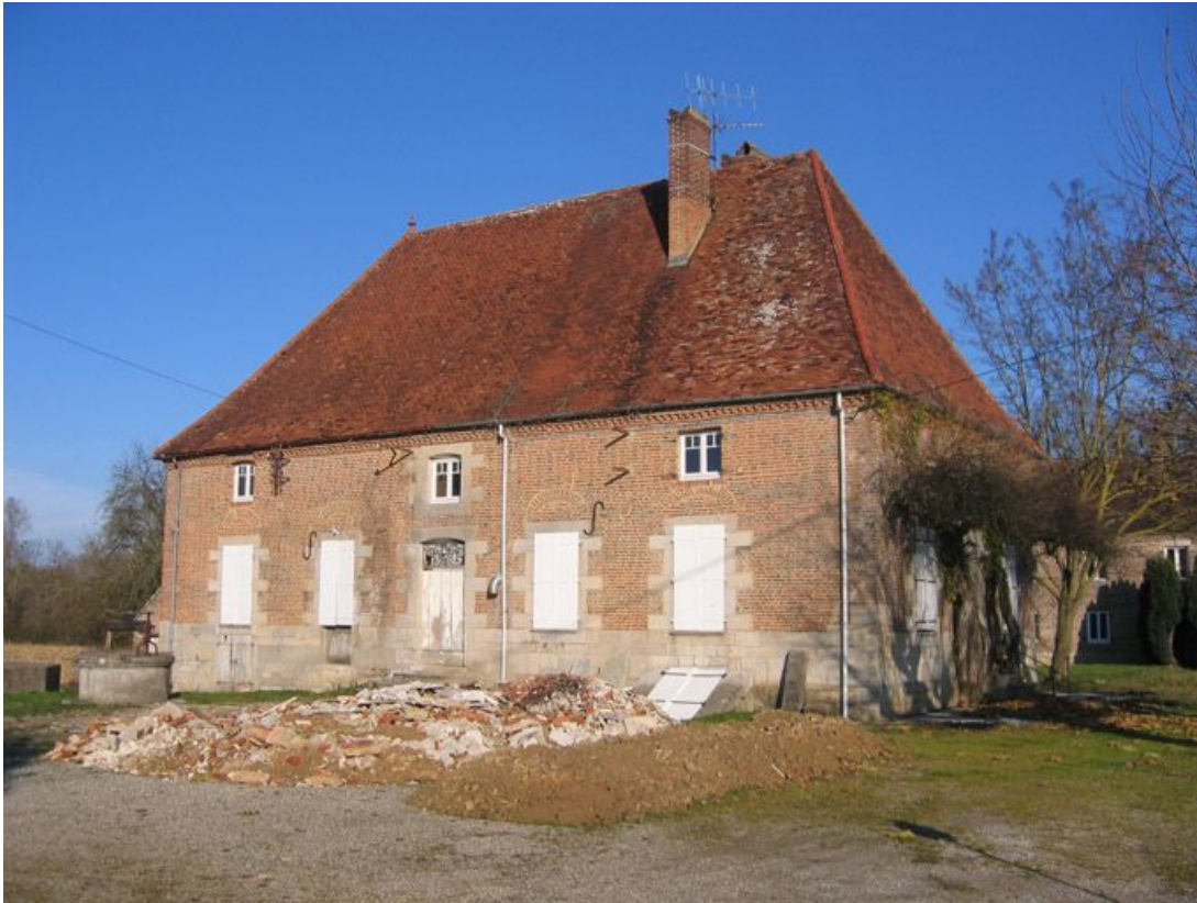
Vue d'ensemble de la façade de l'habitation.
