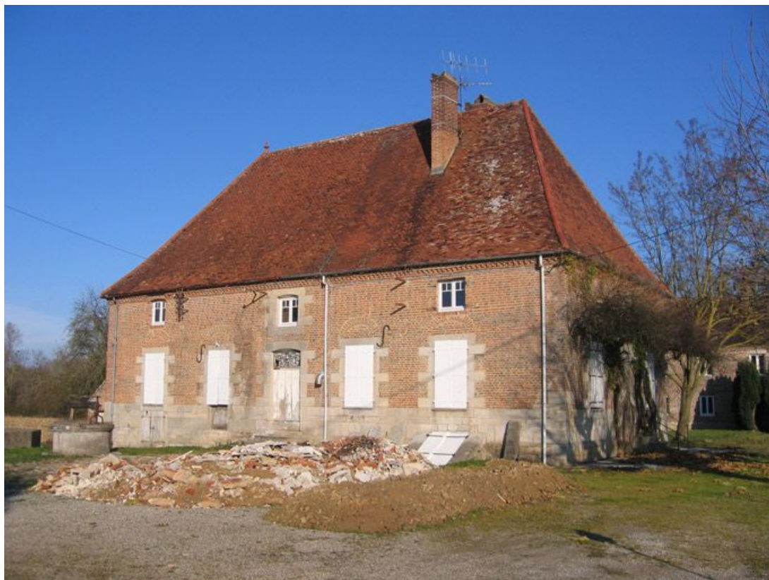
Vue d'ensemble de la façade de l'habitation.
