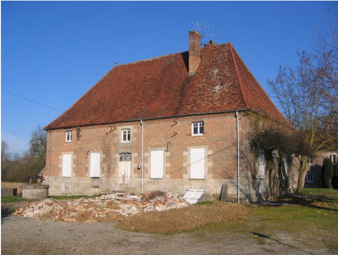
Vue d'ensemble de la façade de l'habitation.
