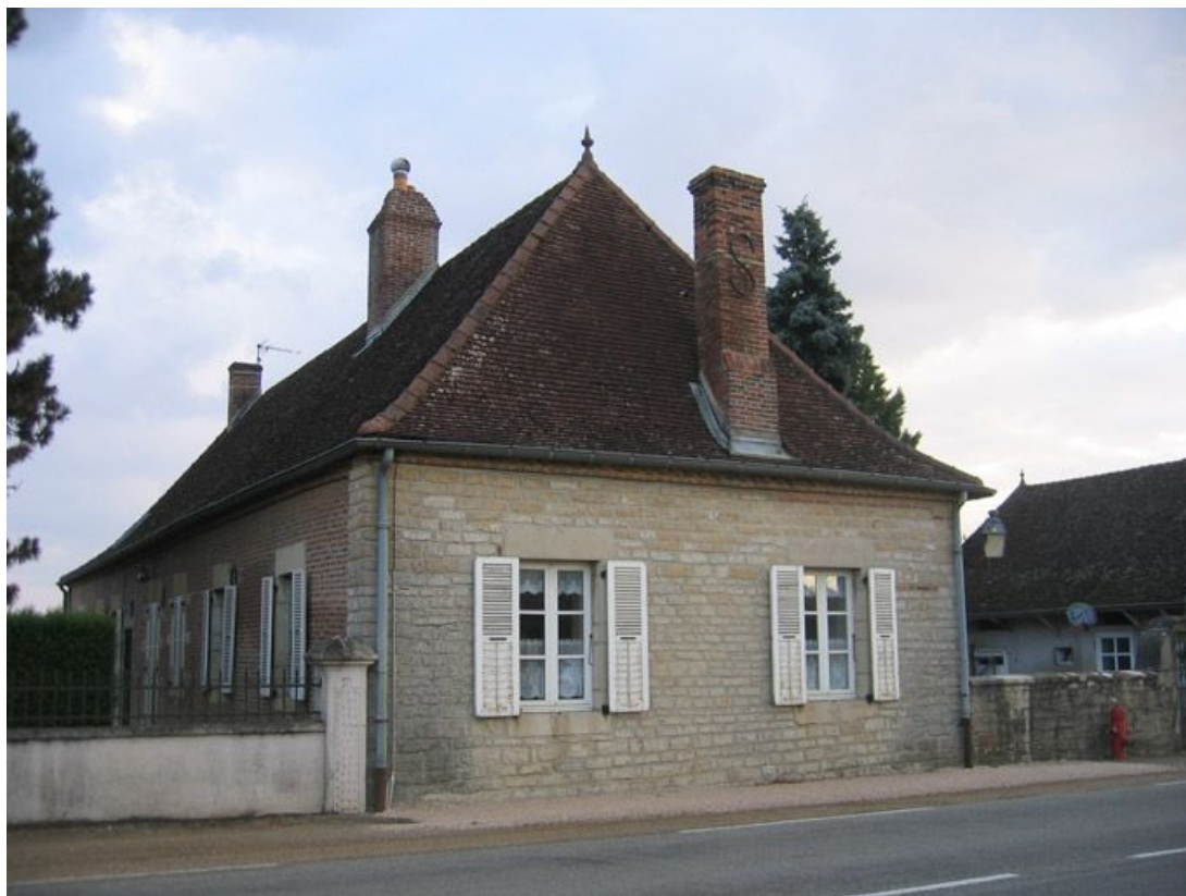
Vue d'ensemble de la façade.
