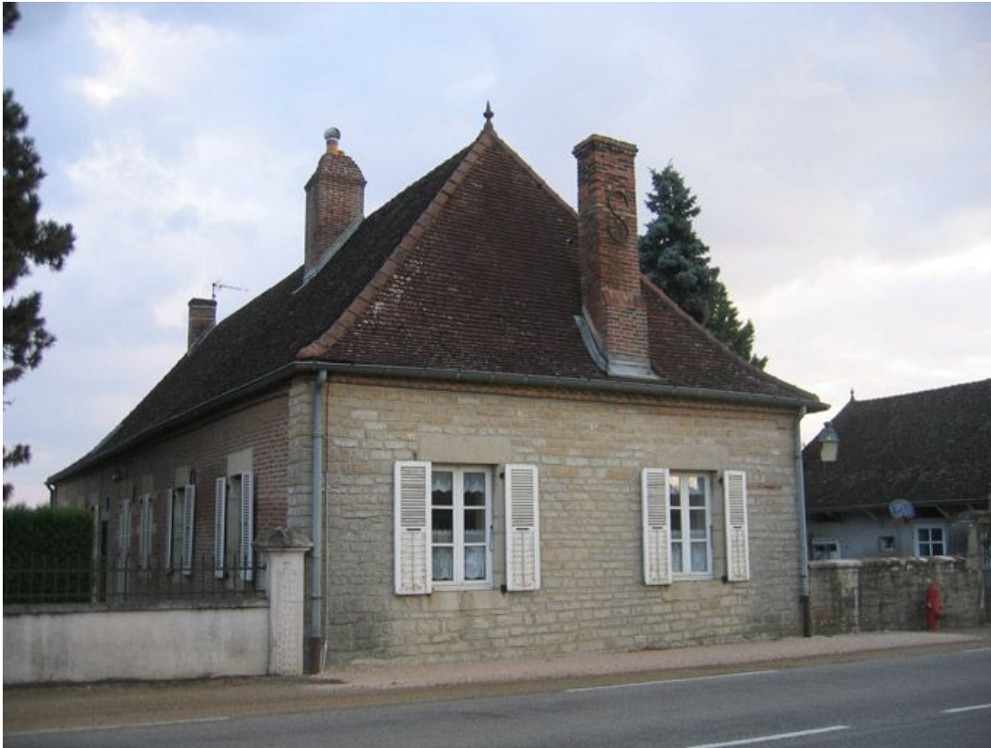
Vue d'ensemble de la façade.
