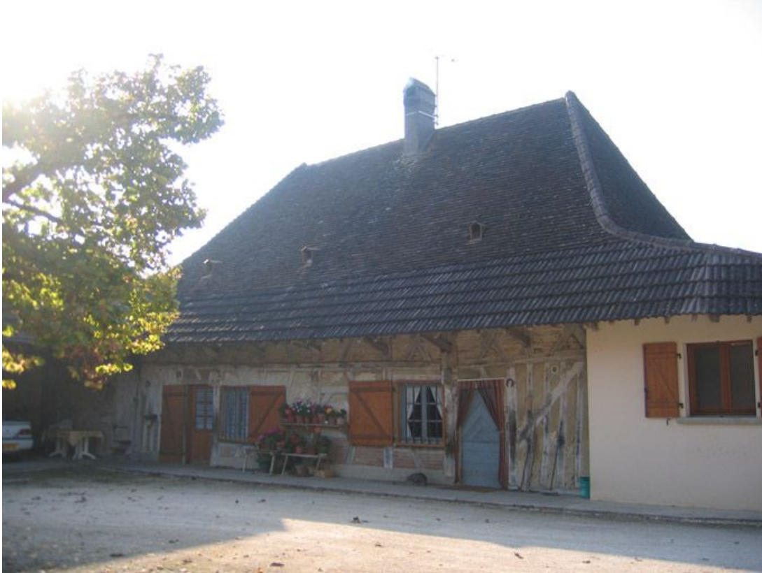
Vue d'ensemble de la façade de l'habitation.
