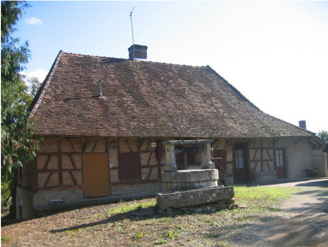
Vue d'ensemble de la façade de l'habitation.
