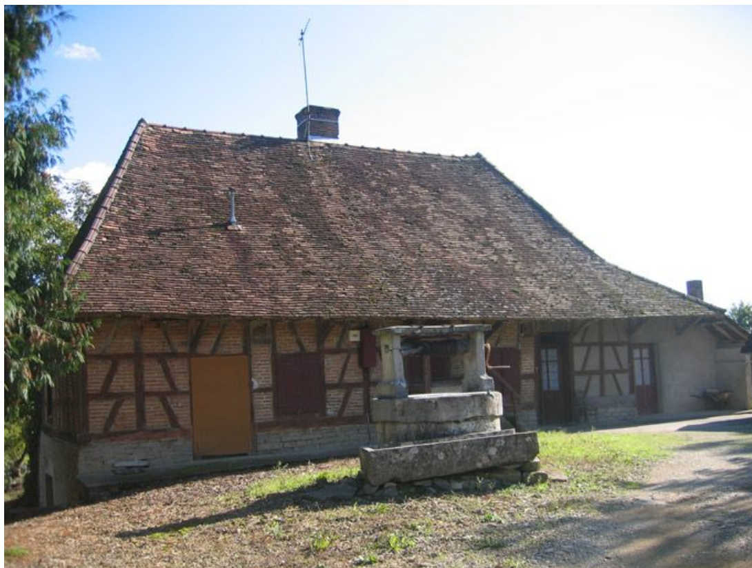
Vue d'ensemble de la façade de l'habitation.
