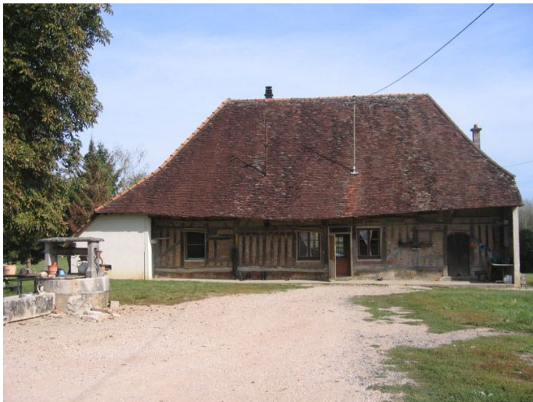
Vue d'ensemble de la façade.
