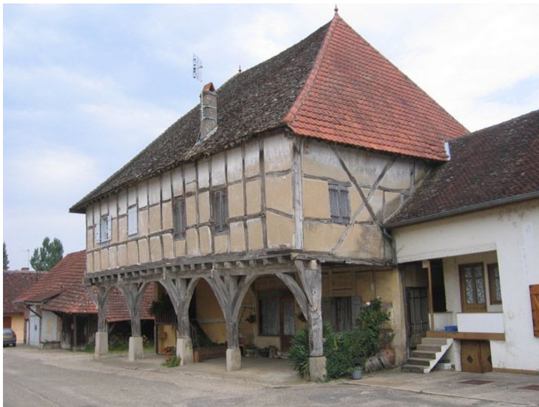
Vue d'ensemble de la façade.
