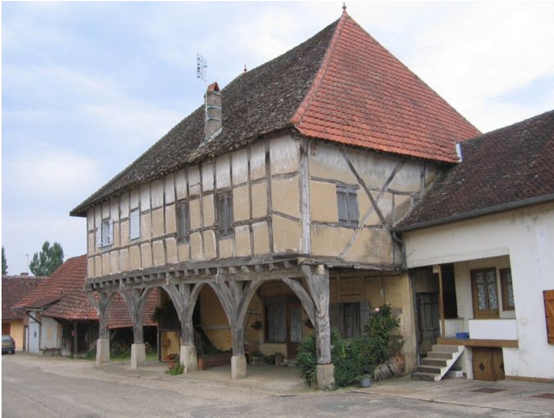
Vue d'ensemble de la façade.
