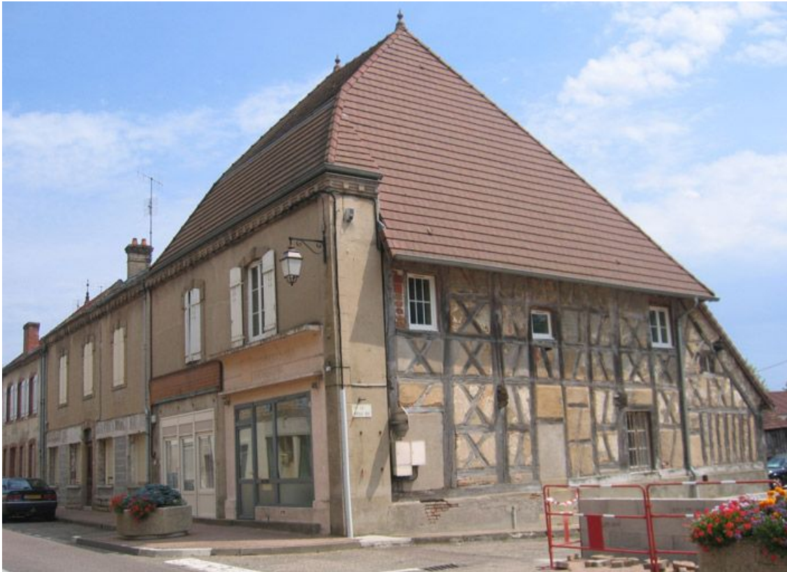
Vue d'ensemble de la façade.
