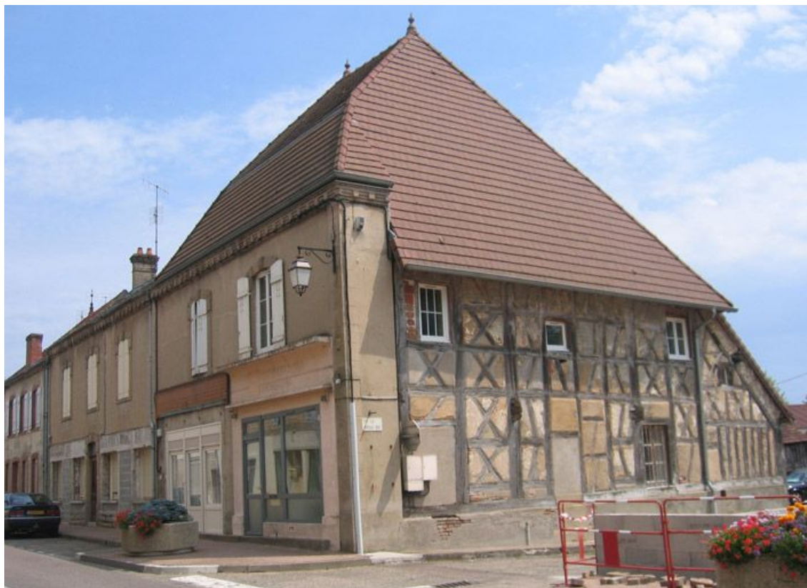
Vue d'ensemble de la façade.
