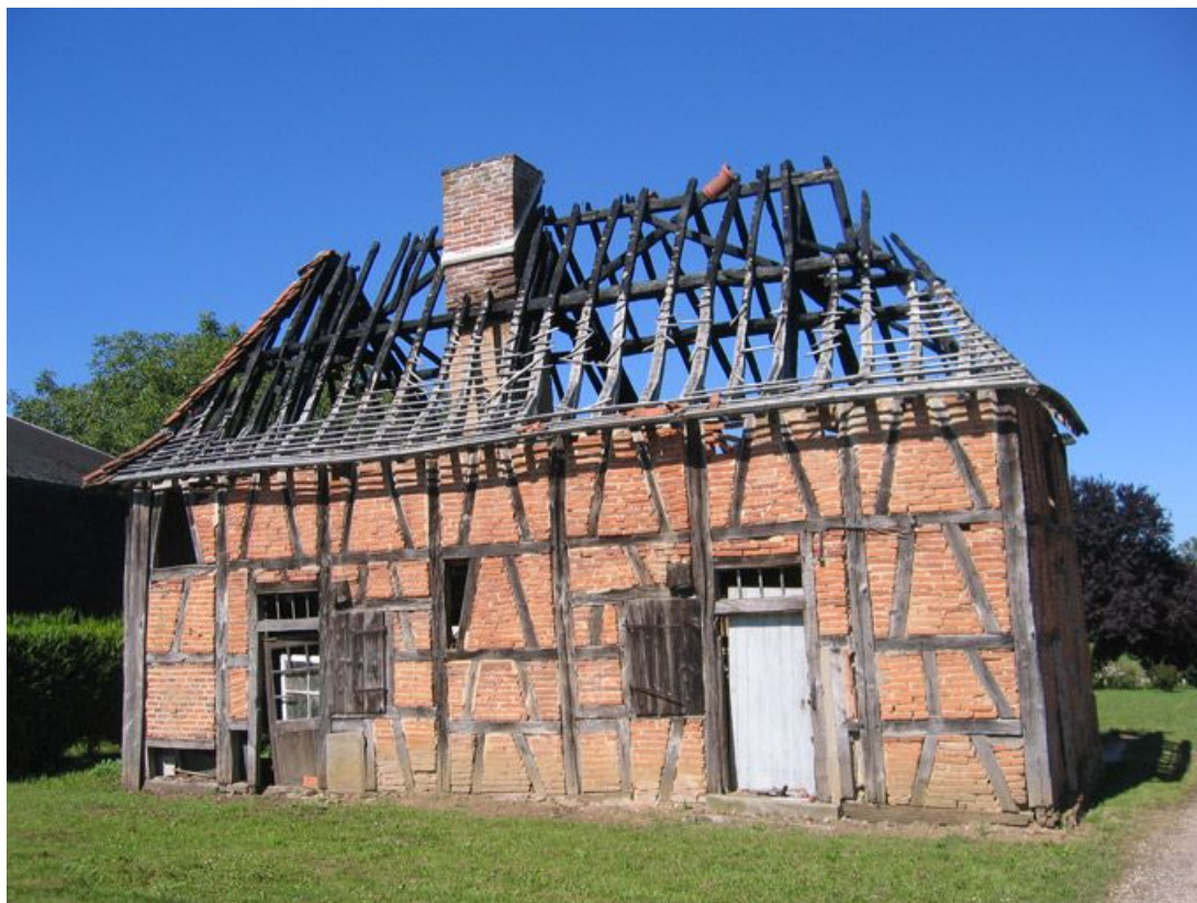
Vue d'ensemble de la façade.
