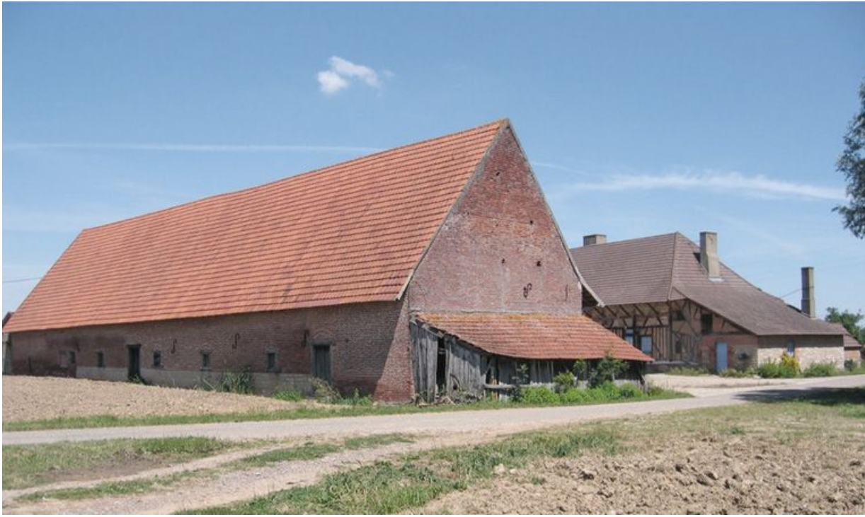
Vue d'ensemble de la façade postérieure du bâtiment des dépendances.
