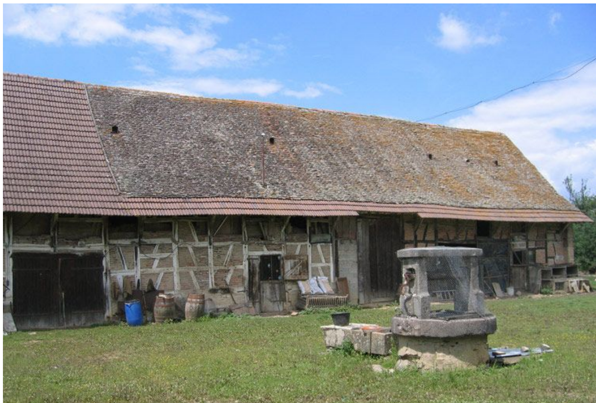
Vue d'ensemble de la façade du bâtiment des dépendances.
