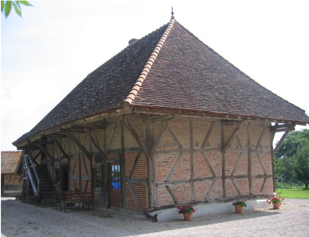
Vue d'ensemble de la façade de l'habitation.
