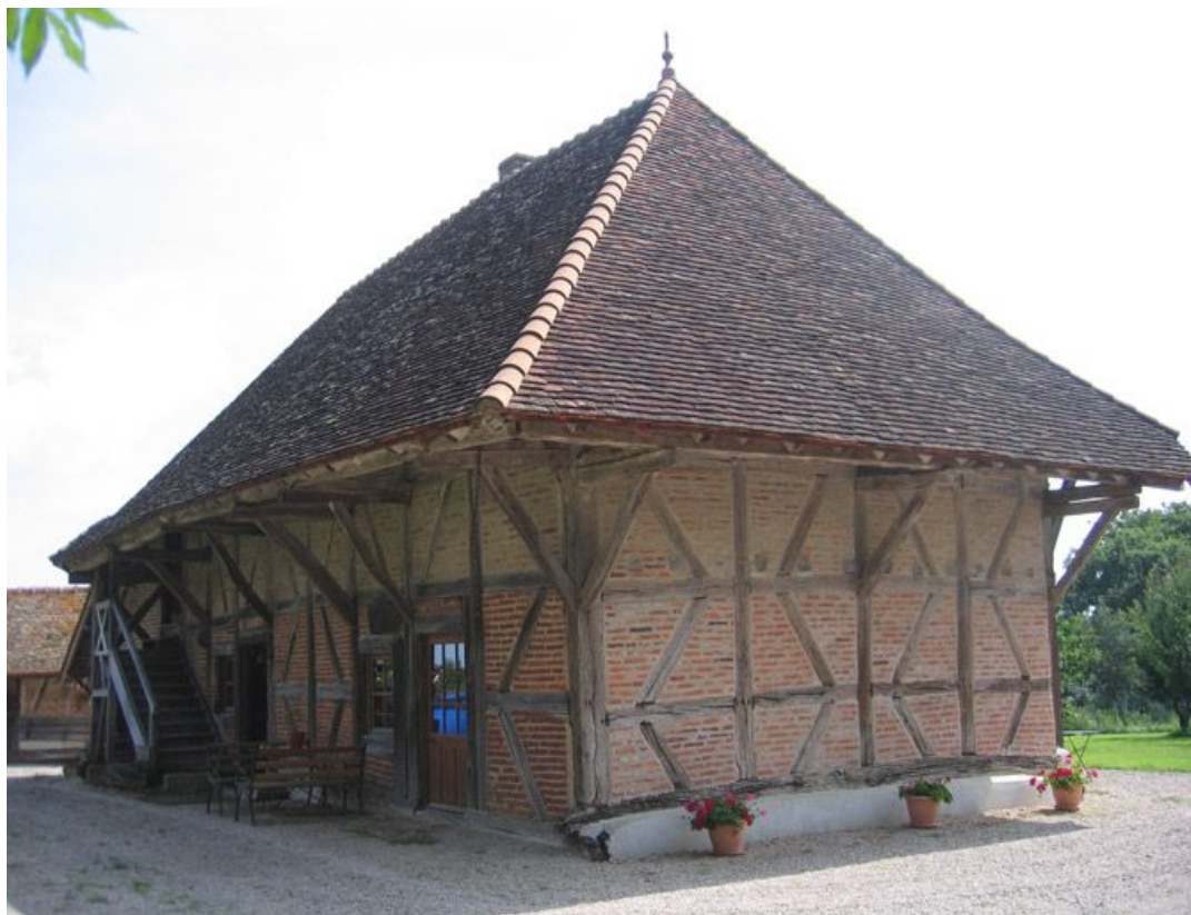
Vue d'ensemble de la façade de l'habitation.
