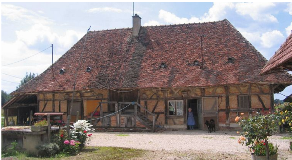
Vue d'ensemble de la façade de l'habitation.
