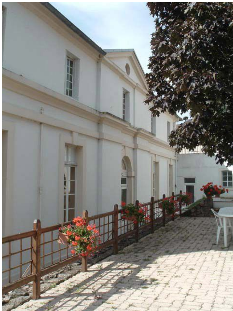
Bâtiment Dalivert (1781-1784), façade antérieure, vue générale latérale, depuis la terrasse du jardin contemporain. 71, Montcenis Eglise
