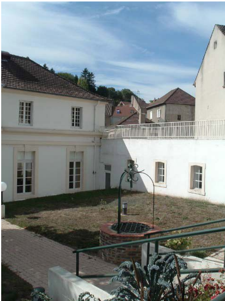
Bâtiment Dalivert (1781-1784), vue partielle de la façade antérieure depuis le bâtiment Caristie (vers 1752), jardin et galerie de liaison contemporaine.
