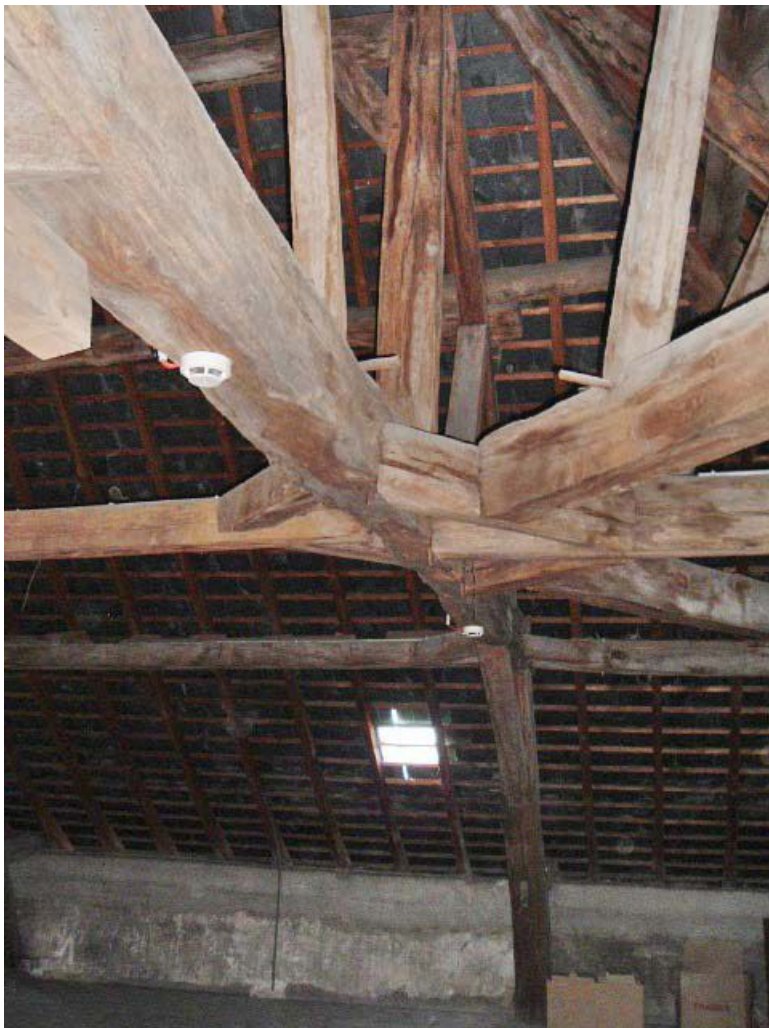
Vue intérieure de la charpente, comble.
