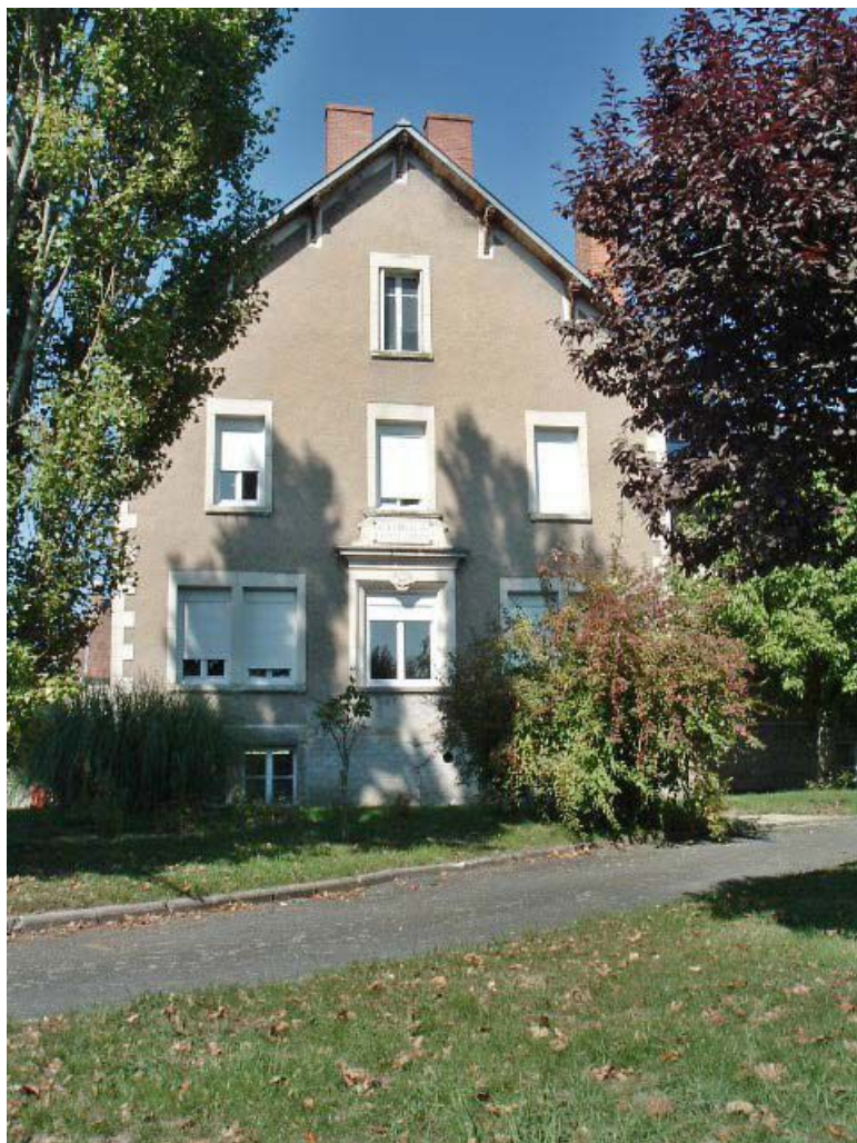
Vue d'ensemble de la façade latérale du bâtiment d'origine, depuis le jardin. 71, Issy-l'Évêque, 7 rue des Emigrés
