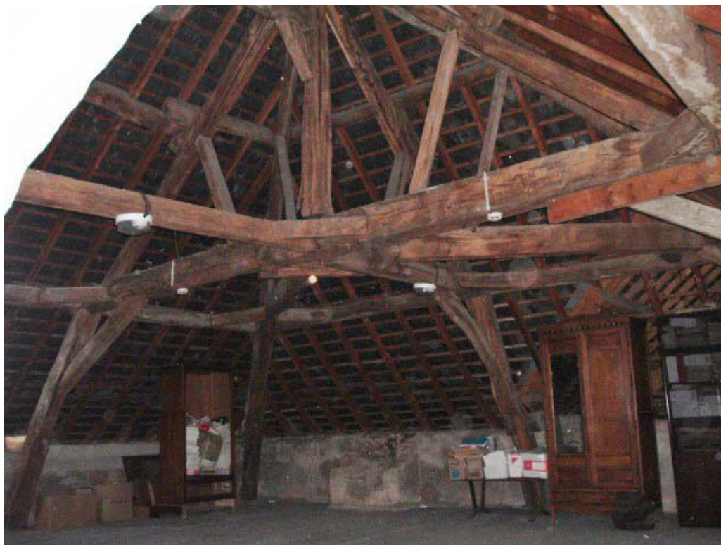
Vue de détail de la charpente, noeud de charpente, comble.
