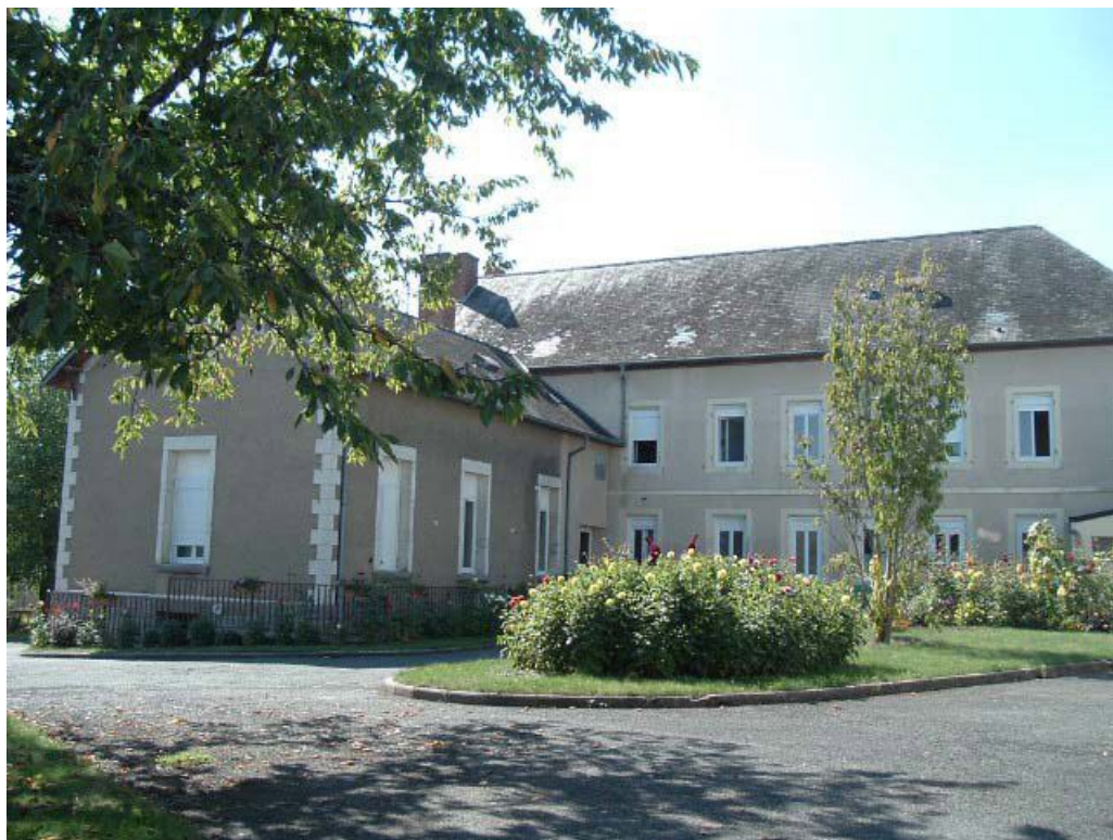
Vue d'ensemble de la façade postérieure.
