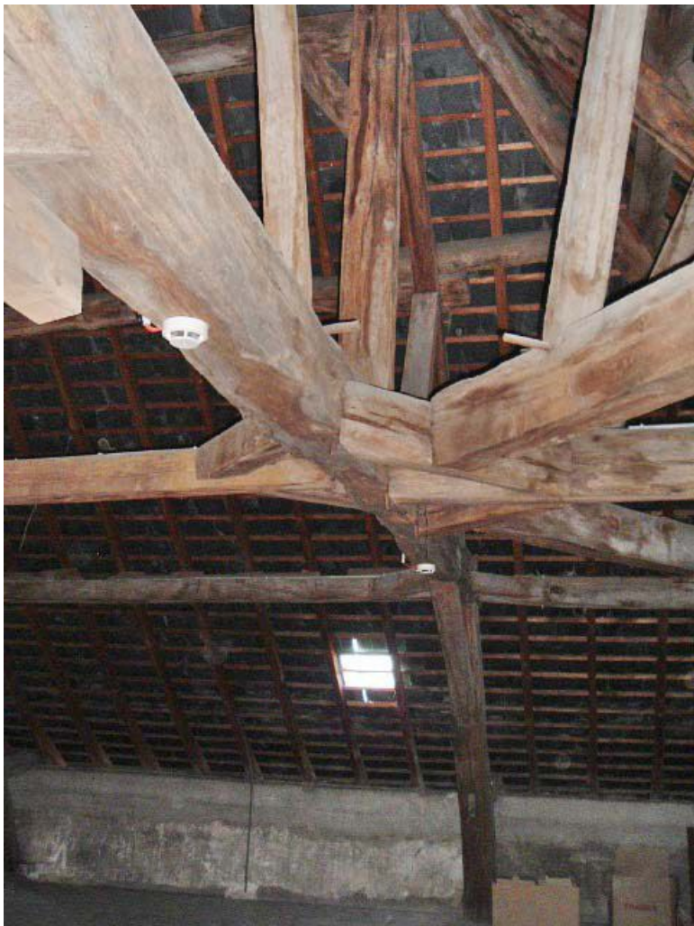
Vue intérieure de la charpente, comble.
