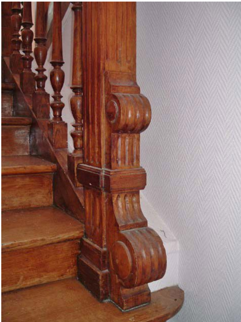
Vue de détail du départ de l'escalier d'origine, décor de volutes et cannelures, balustres en bois tourné. 71, Issy-l'Évêque, 7 rue des Emigrés
