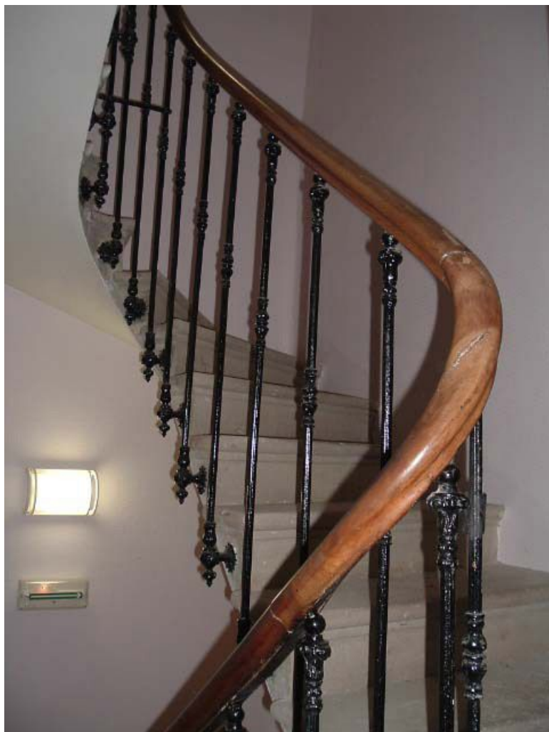
Vue intérieure d'un escalier secondaire d'origine, en fonte.
