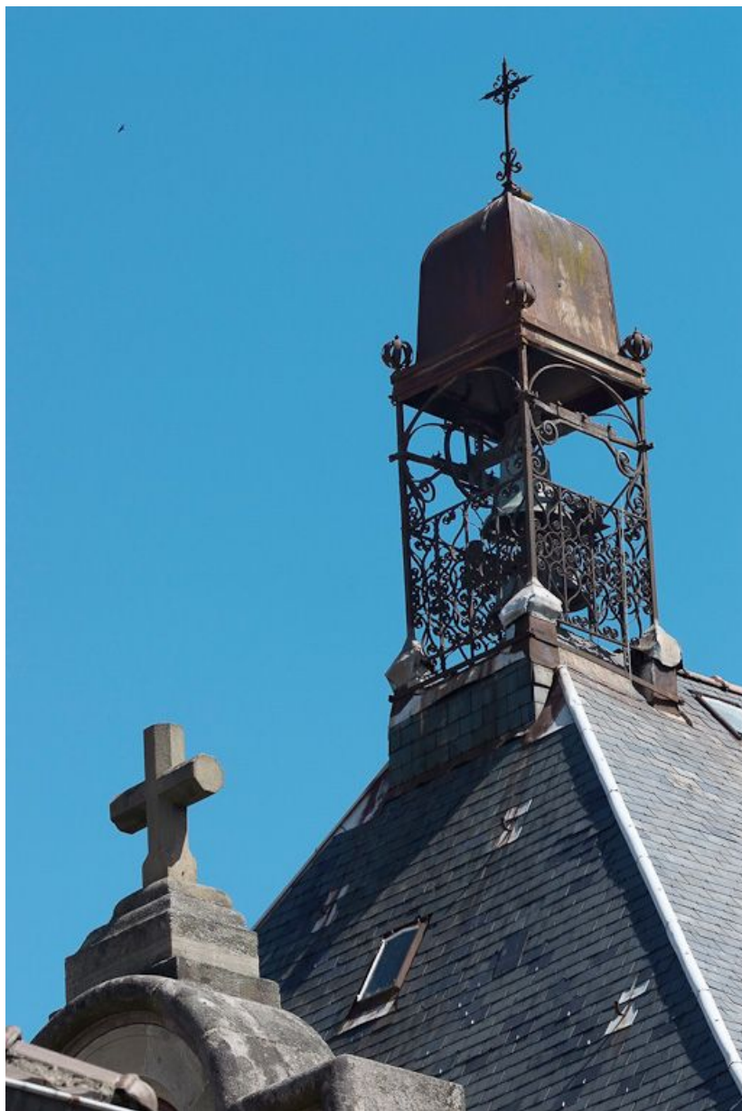
Campanile et croix du fronton de la chapelle. 71, Autun, 9 boulevard Frédéric-Latouche
