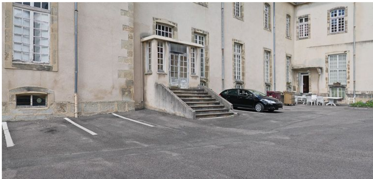
Angle formé par l'aile gauche et le corps central : détail du rez-de-chaussée.
