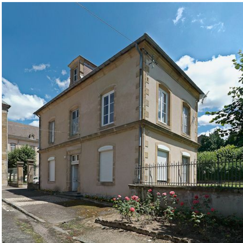
Bâtiment bordant l'allée de la chapelle à droite.
