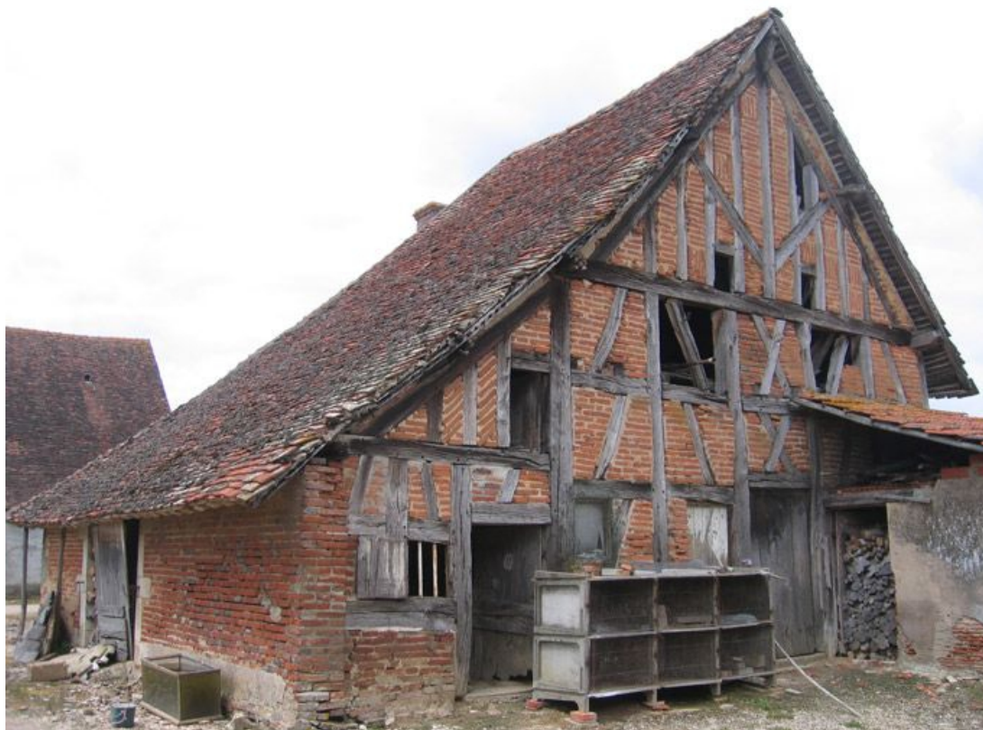
Vue d'ensemble de la façade antérieure.
