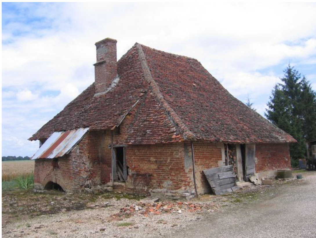
Vue d'ensemble de la façade postérieure.
