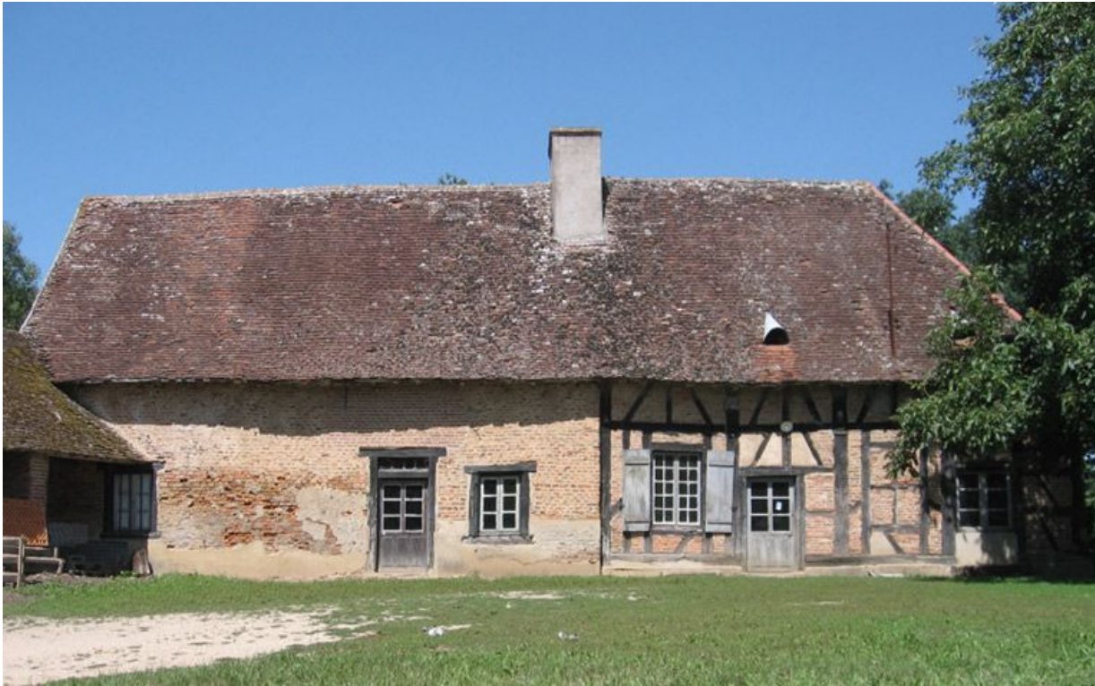
Vue d'ensemble de la façade de l'habitation.
