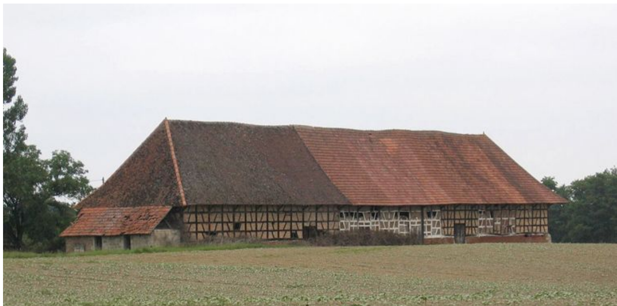
Vue d'ensemble de la façade du bâtiment des dépendances.
