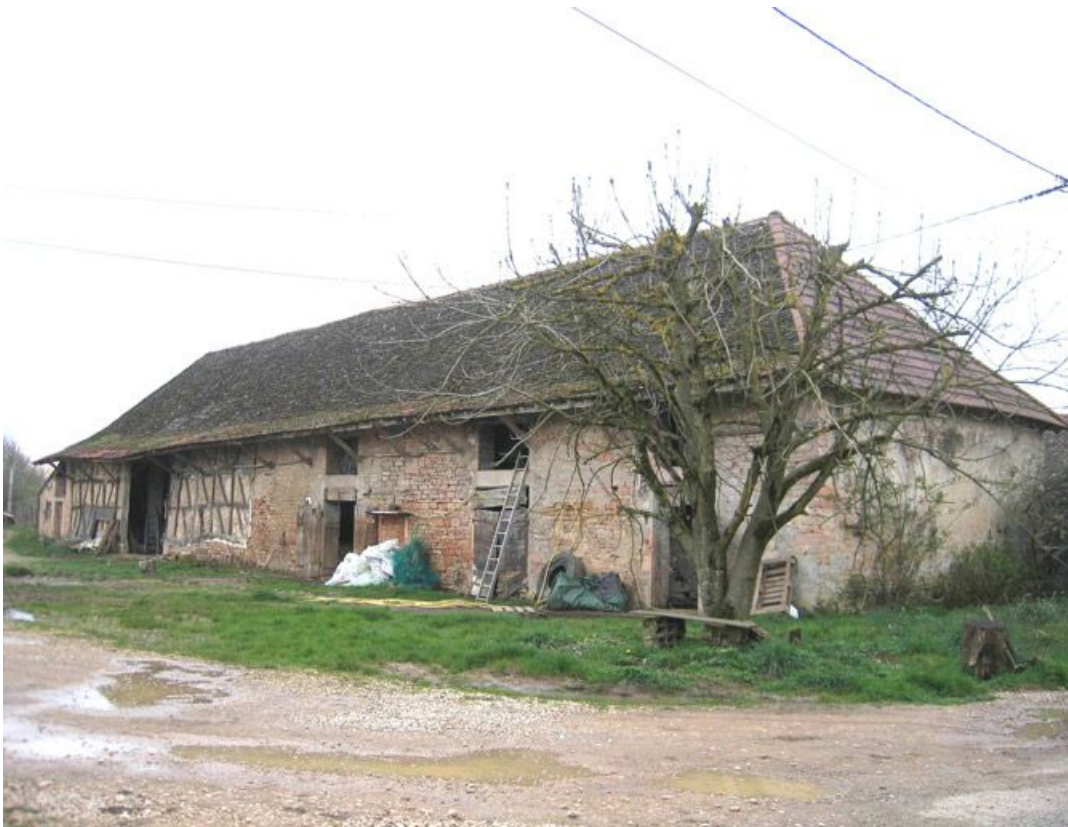
Vue d'ensemble de la façade du bâtiment des dépendances.
