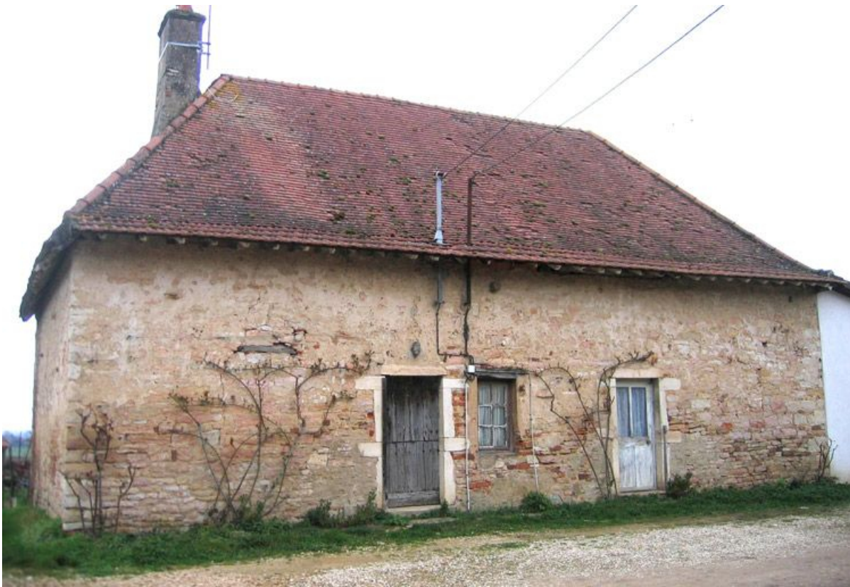
Vue d'ensemble de la façade de l'habitation.
