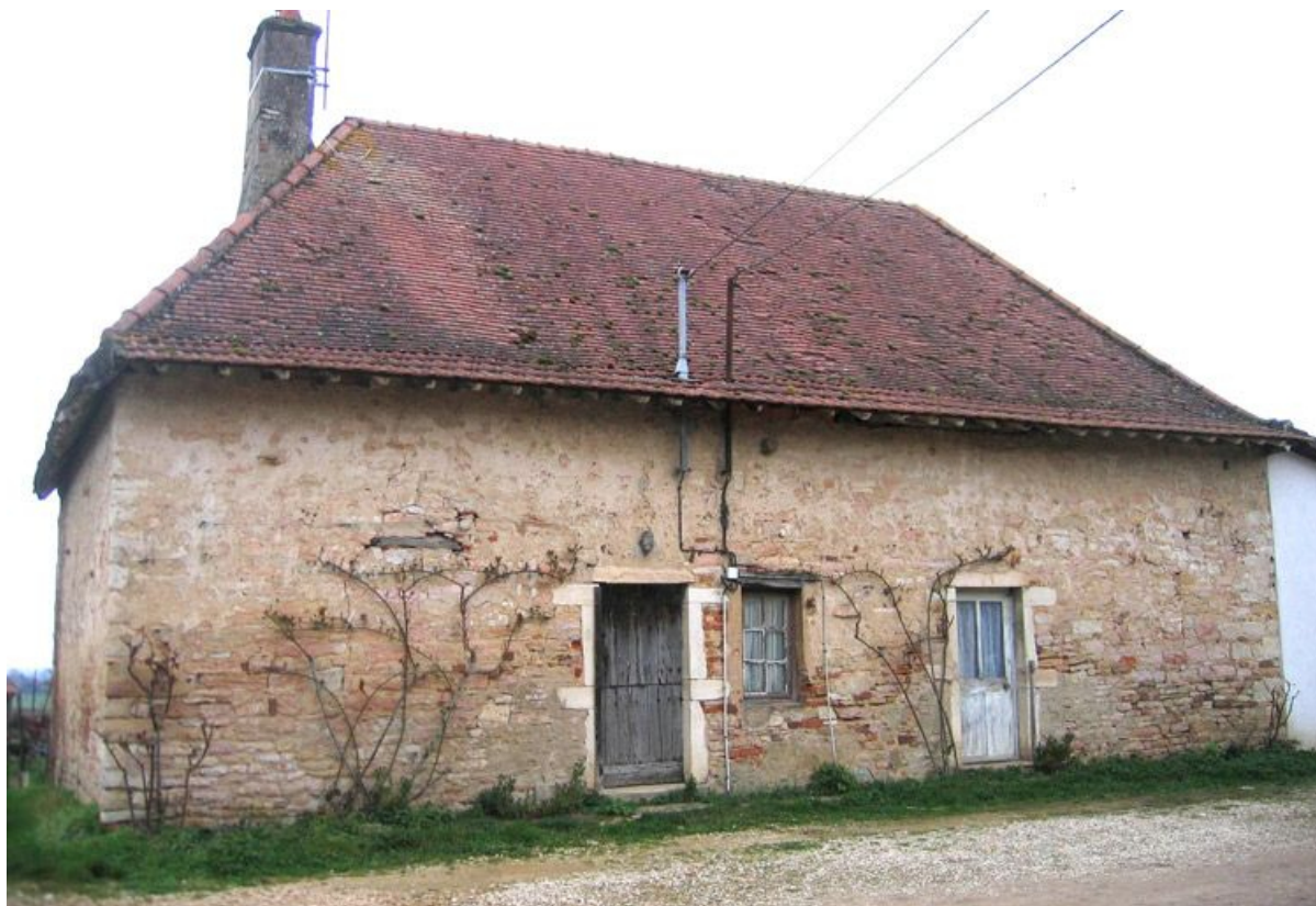
Vue d'ensemble de la façade de l'habitation.
