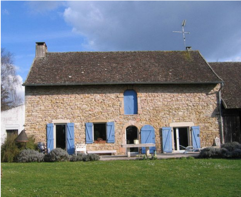
Vue d'ensemble de la façade de l'habitation.
