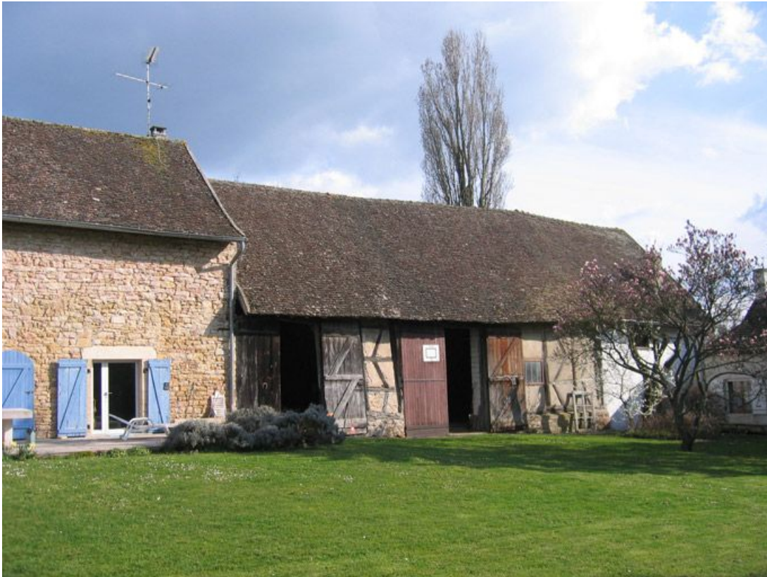
Vue d'ensemble de la façade du bâtiment des dépendances. 71, Ormes
