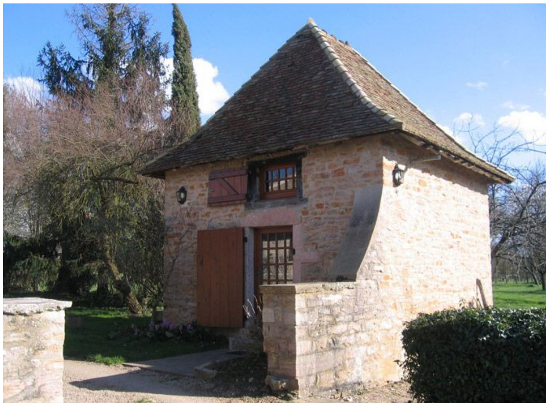
Vue d'ensemble de la façade d'une petite dépendance.
