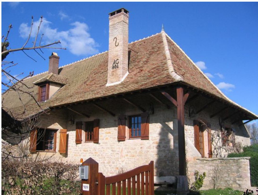
Vue d'ensemble de la façade postérieure.
