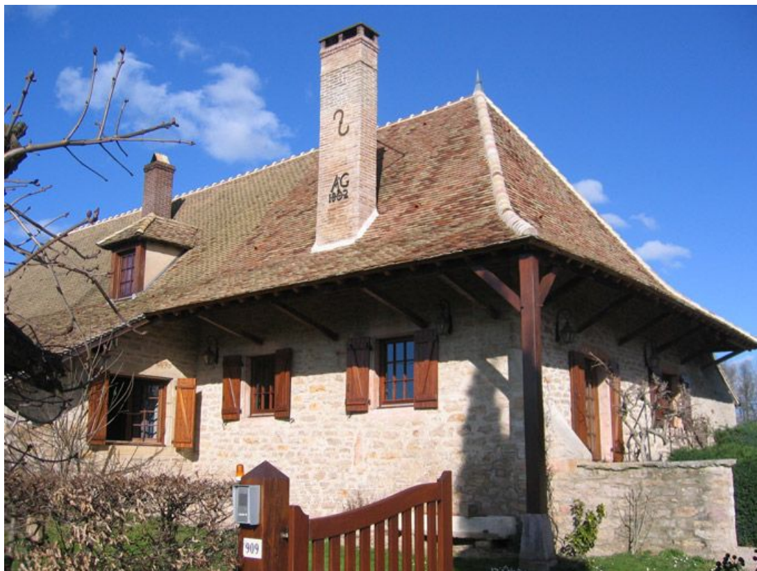
Vue d'ensemble de la façade postérieure.
