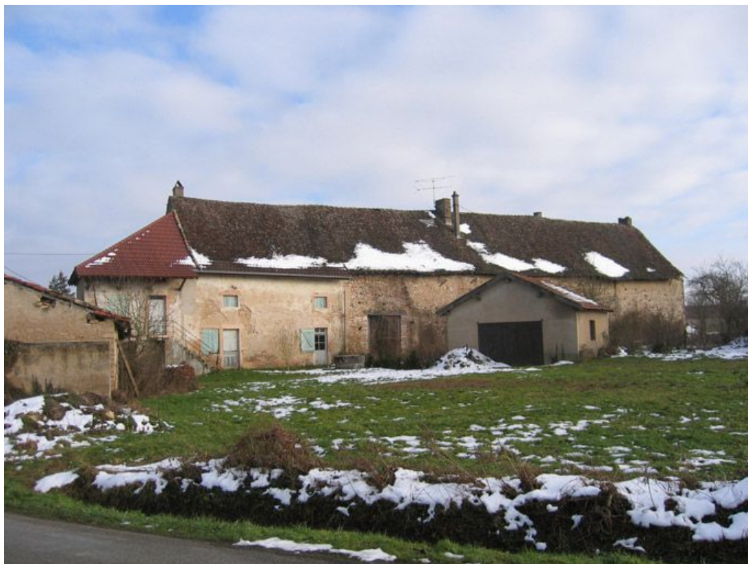
Vue d'ensemble de la façade postérieure.
