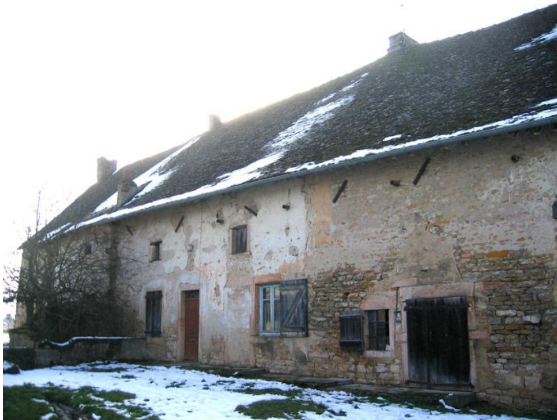
Vue d'ensemble de la façade antérieure.
