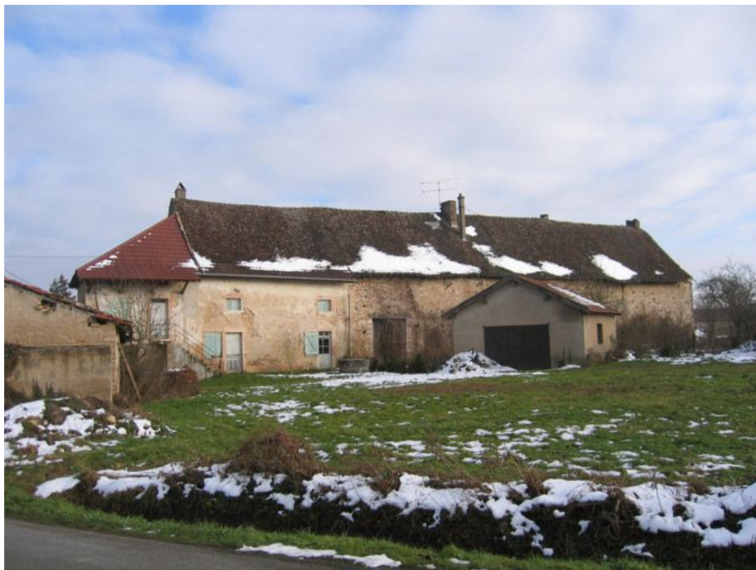
Vue d'ensemble de la façade postérieure.
