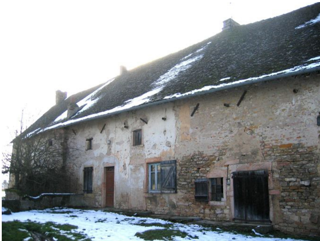
Vue d'ensemble de la façade antérieure.
