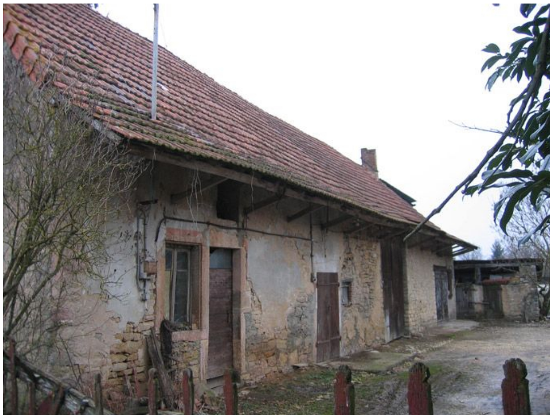
Vue d'ensemble de la façade.
