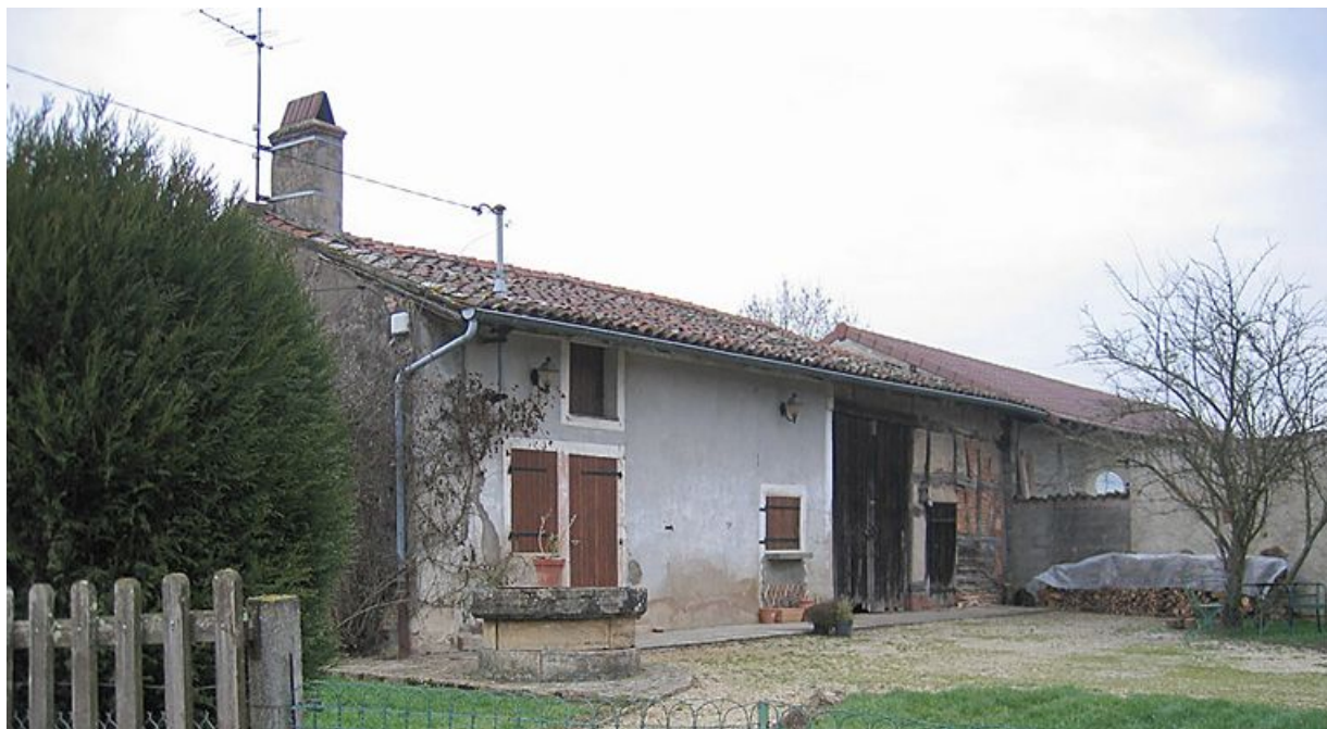
Vue d'ensemble de la façade.
