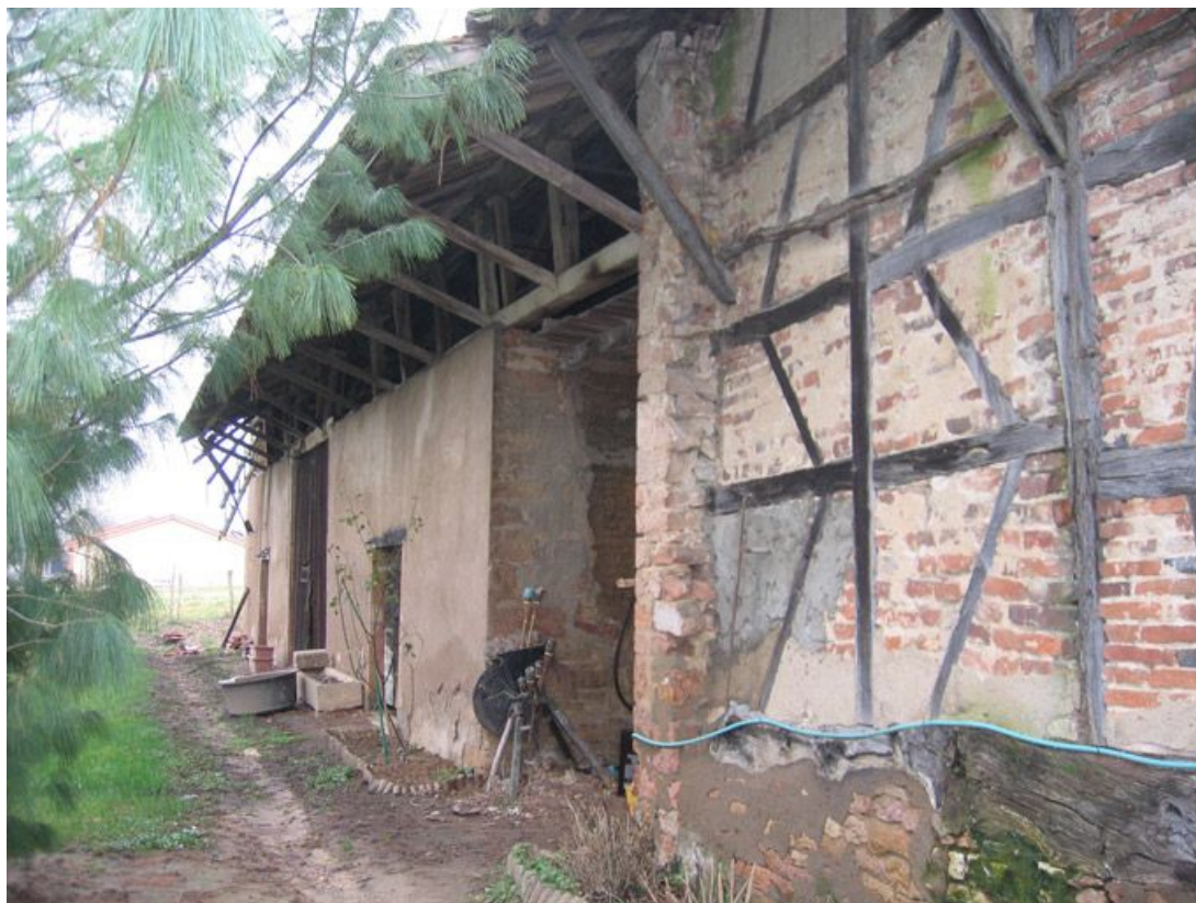
Vue d'ensemble de la façade.
