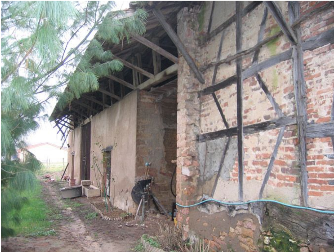
Vue d'ensemble de la façade.
