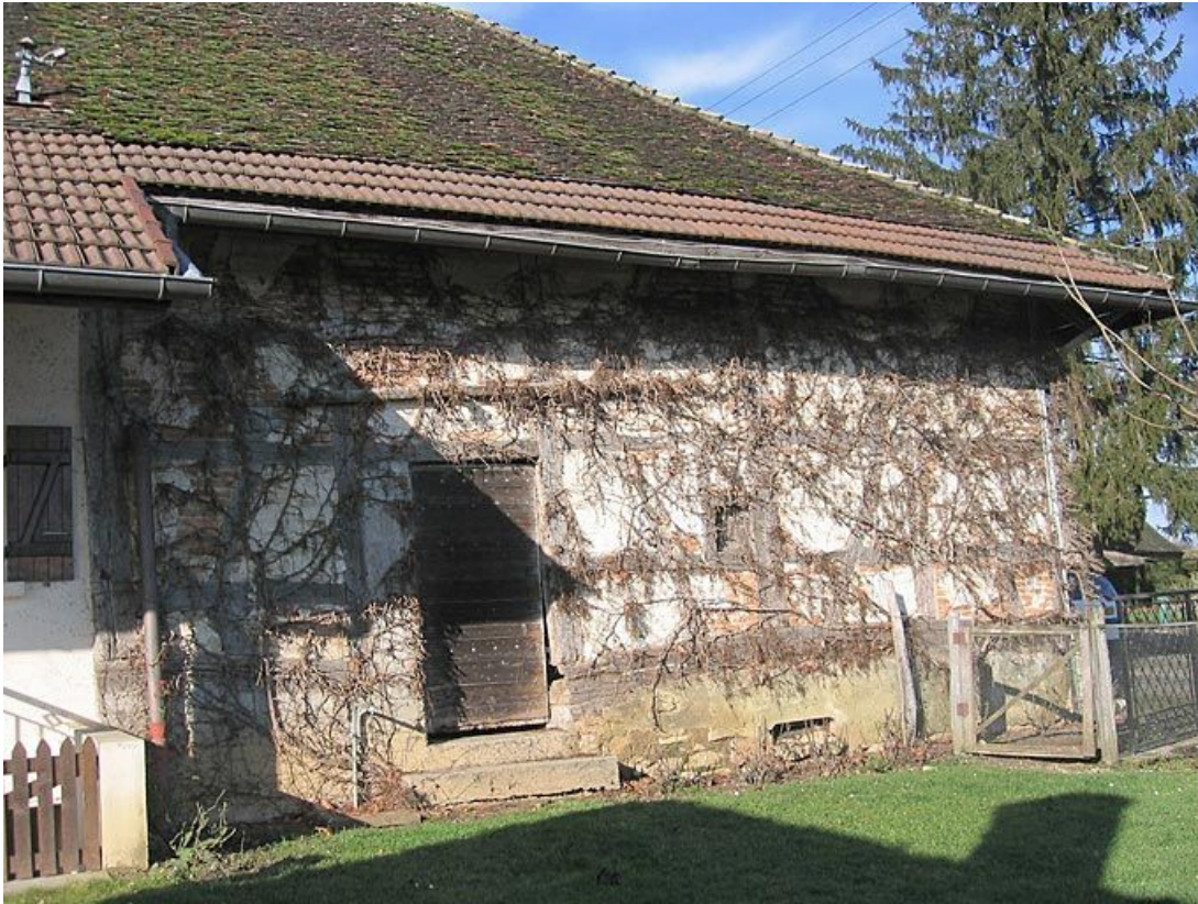
Vue d'ensemble de la façade.
