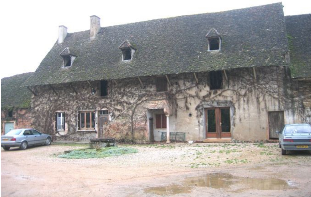
Vue d'ensemble de la façade.
