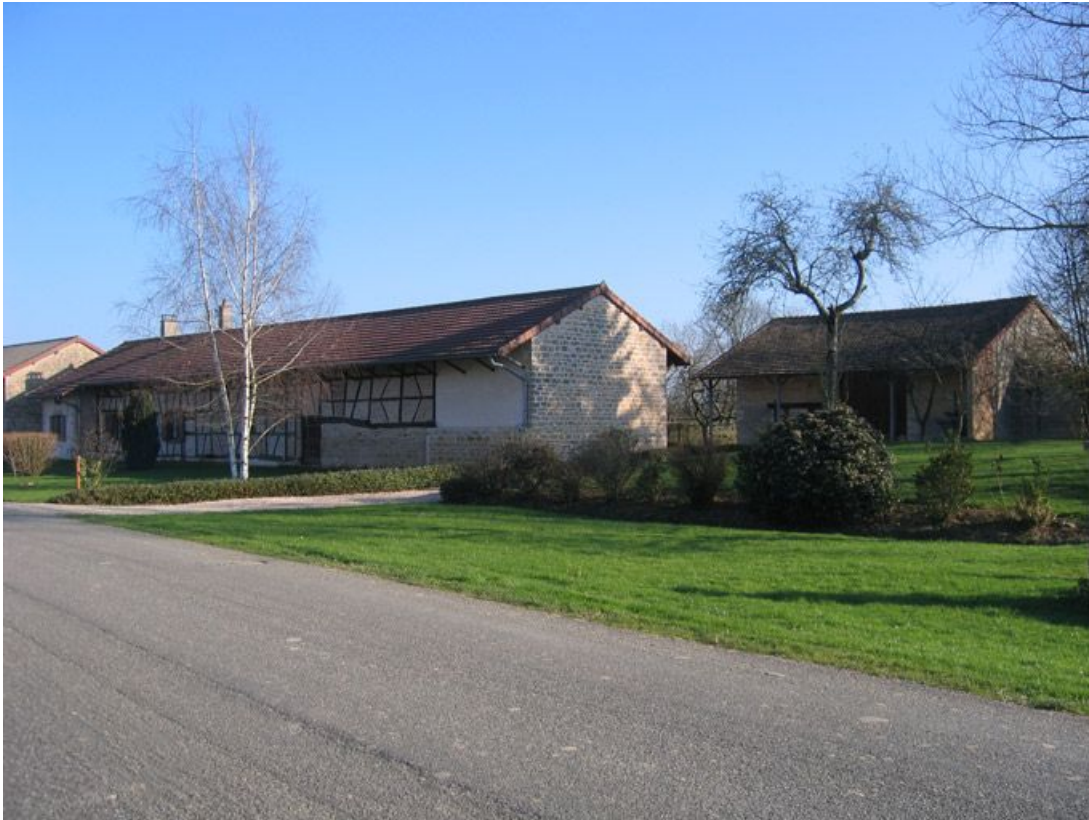
Vue d'ensemble de la façade.
