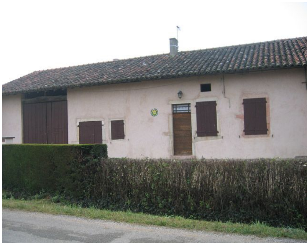
Vue d'ensemble de la façade antérieure.
