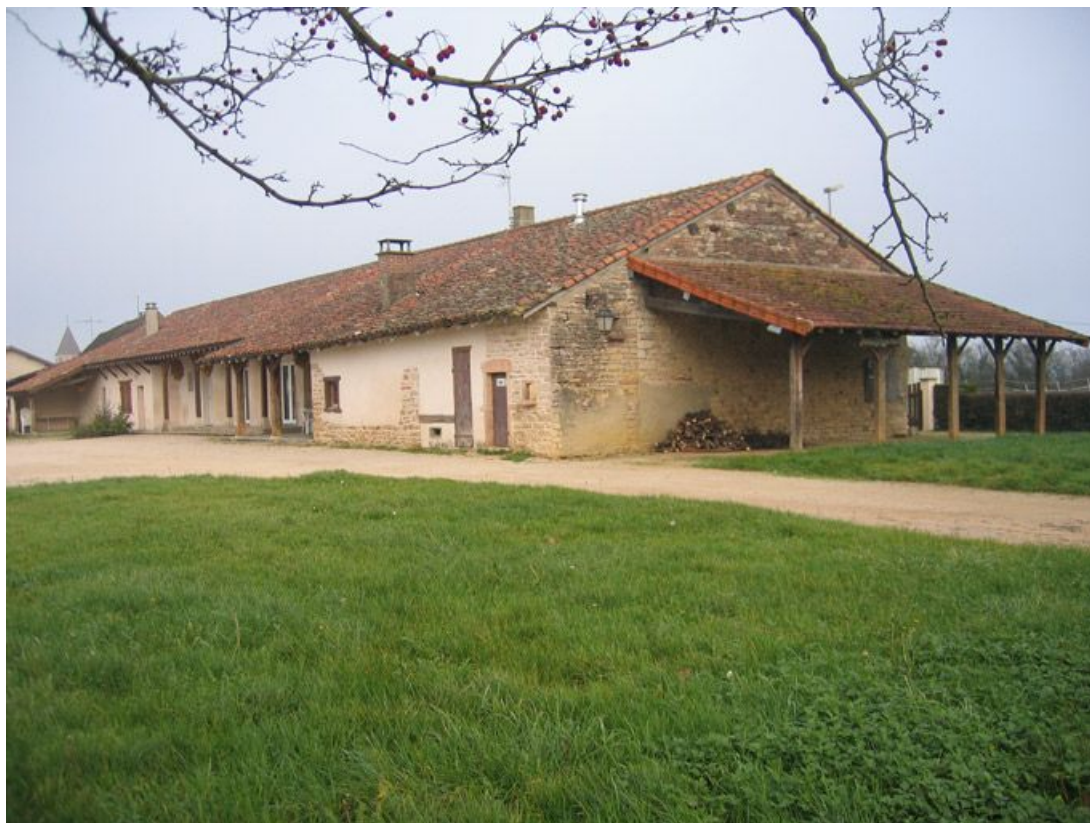
Vue d'ensemble de la façade postérieure.
