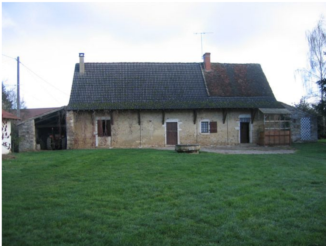
Vue d'ensemble de la façade de l'habitation.
