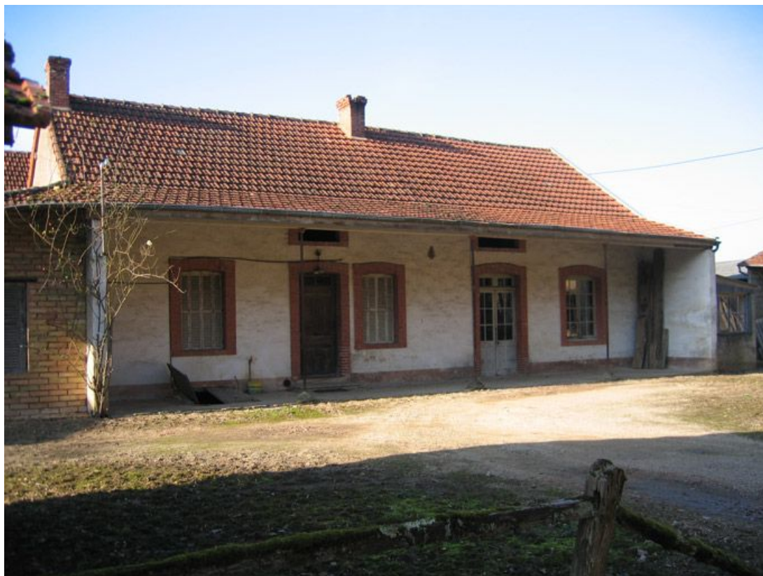
Vue d'ensemble de la façade.
