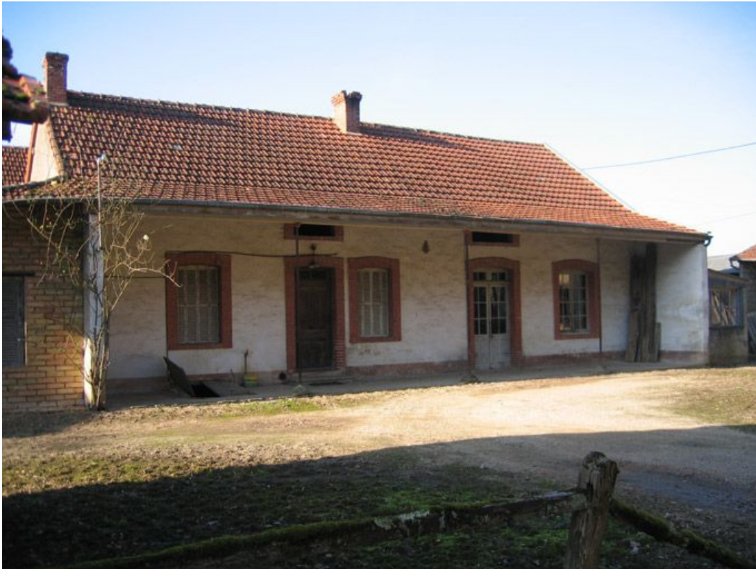
Vue d'ensemble de la façade.
